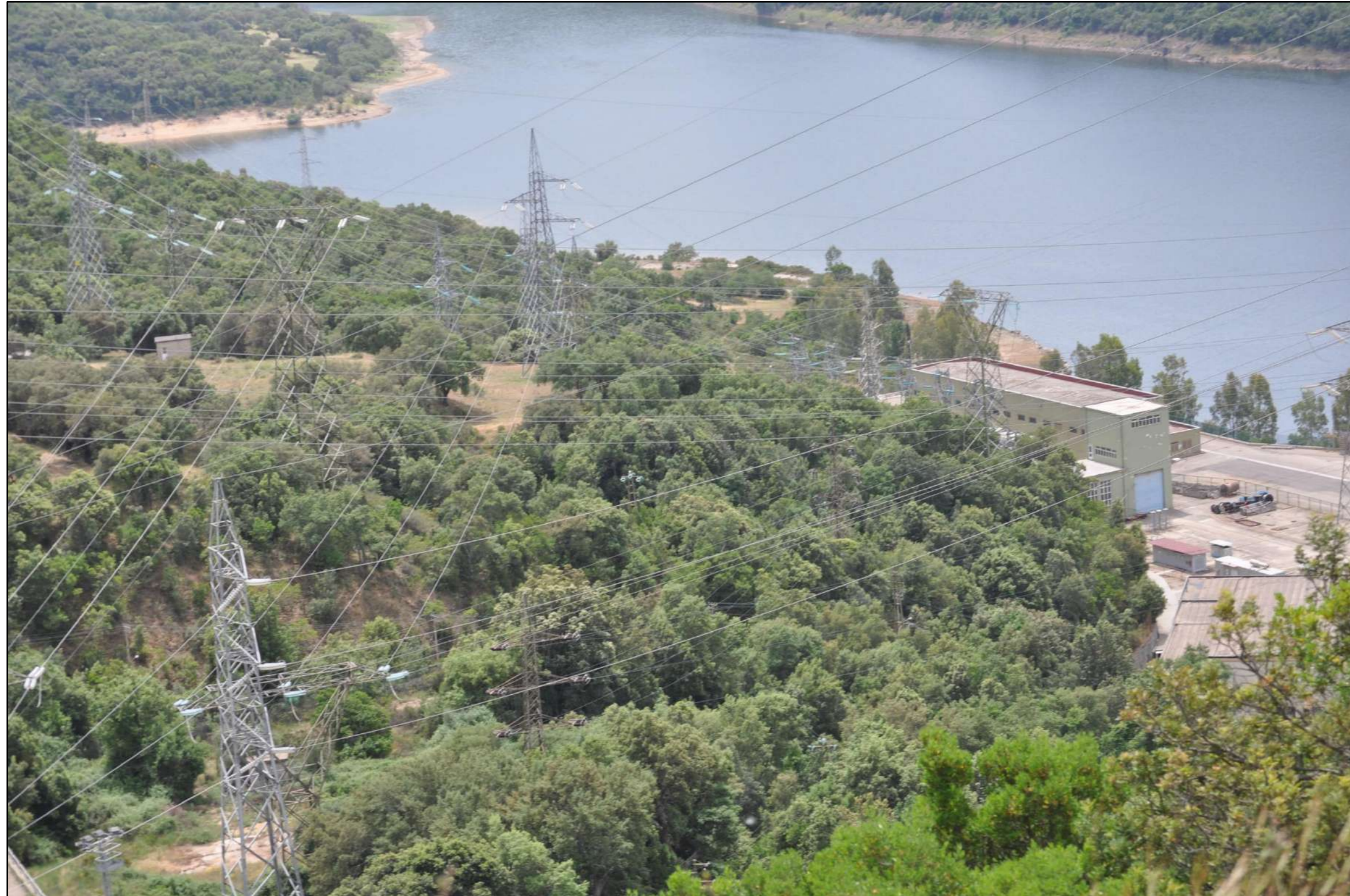
Figura 4.1.2.1c (1di2) Vista arenile da PV2 Stato Attuale
