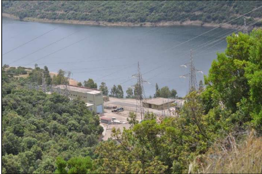
Figura 2.2.3d Centrale ENEL ubicata sulle sponde del Lago di Cucchinadorza
