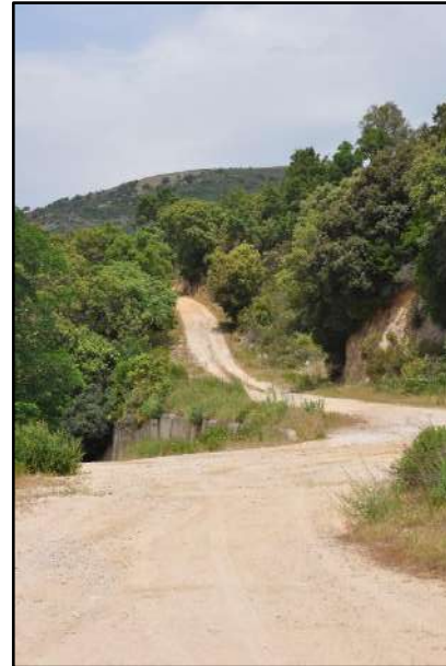
Figura 2.2.3b Strada di accesso alla Camera Valvole
