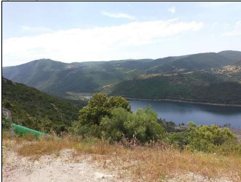
Figura 2.2.3g Vista dell'Area di Studio dall'ubicazione della camera valvole
