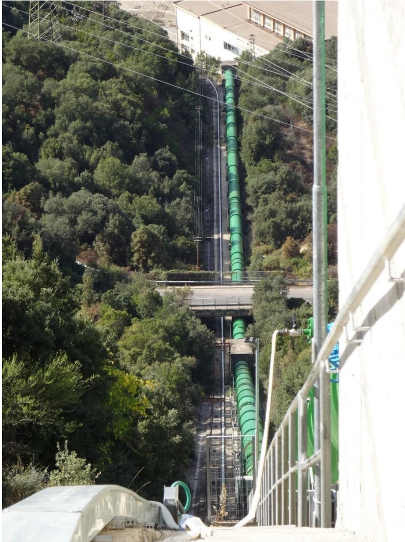
Figura 14: Condotta forzata – Sopralluogo Lombardi 2021.
