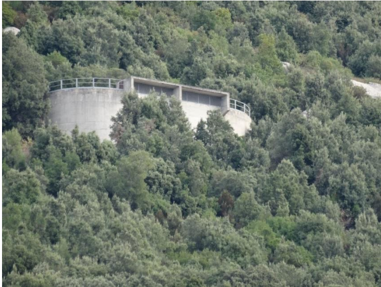
Figura 11: Parte sommitale del pozzo di oscillazione di monte – Sopralluogo Lombardi 2021.
