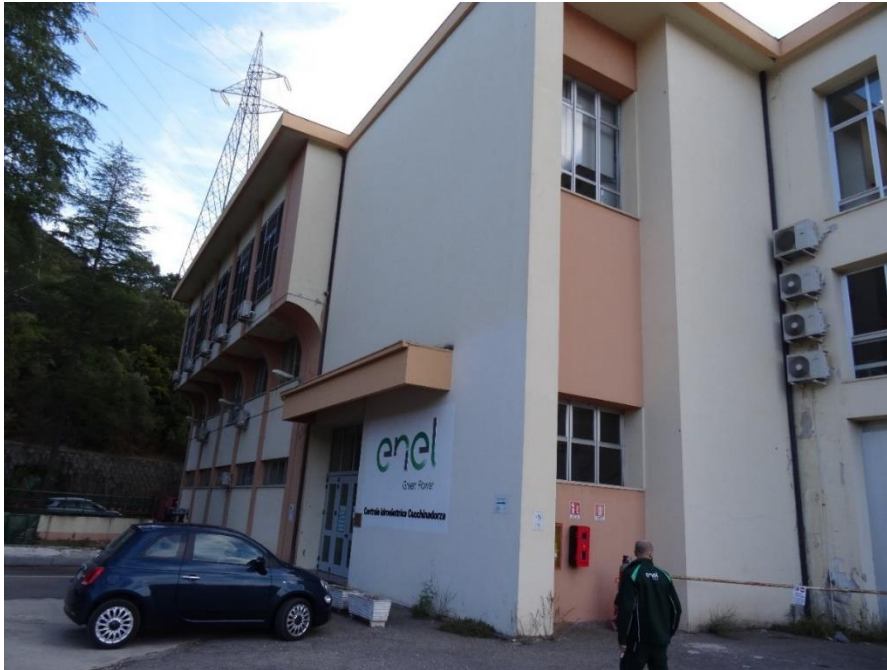
Figura 17: Edificio della centrale – vista da Sud – Sopralluogo Lombardi 2021.
