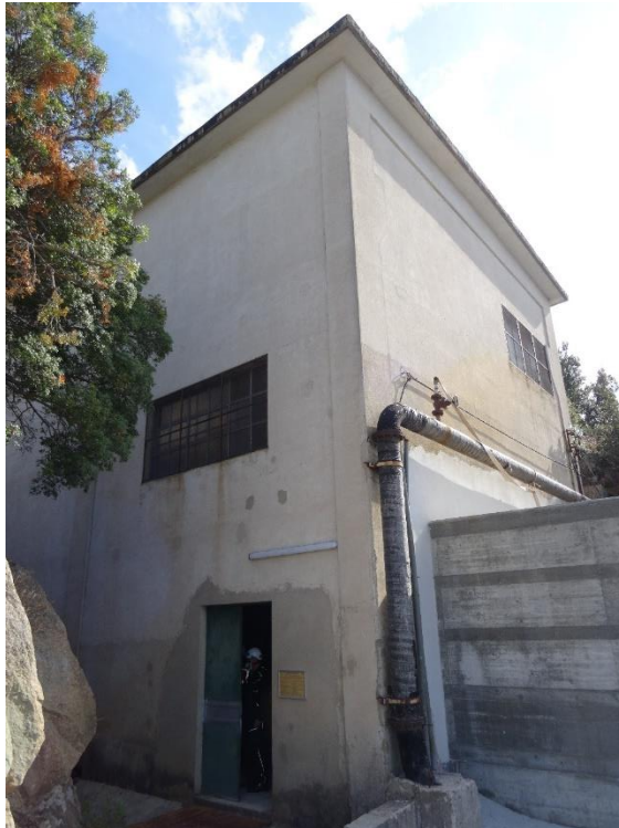
Figura 12: Camera valvole – esterno – Sopralluogo Lombardi 2021.
