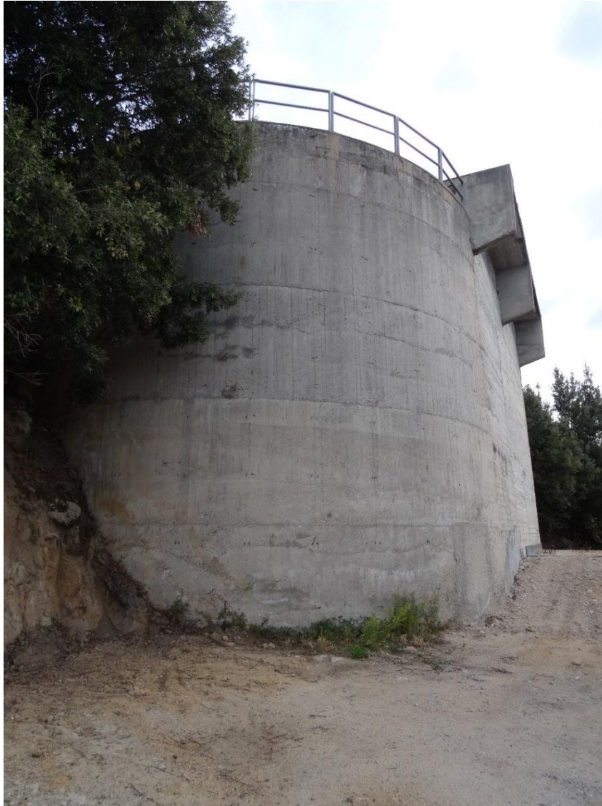
Figura 10: Parte sommitale del pozzo di oscillazione di monte – Sopralluogo Lombardi 2021.
