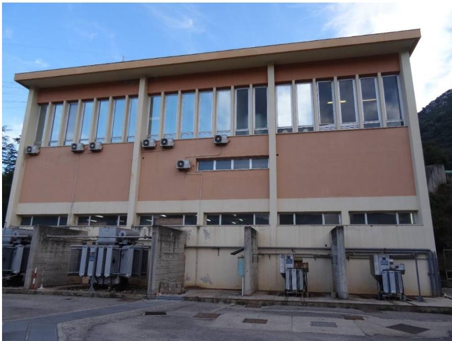
Figura 16: Edificio della centrale – vista da Sud-Ovest – Sopralluogo Lombardi 2021.
