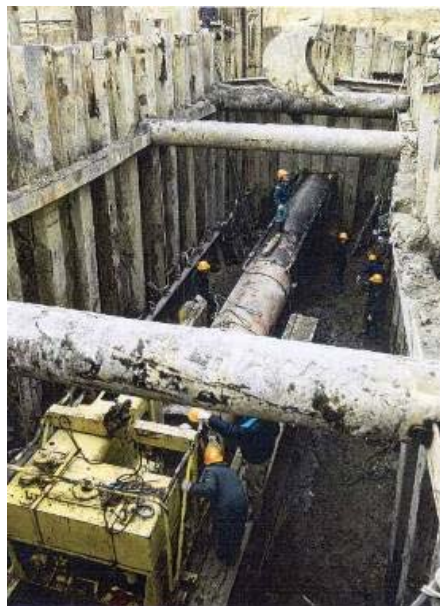
Foto 2.2-7: Trivellazione con spingitubo
