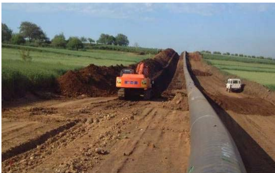
Foto 2.2-3: Scavo della trincea
