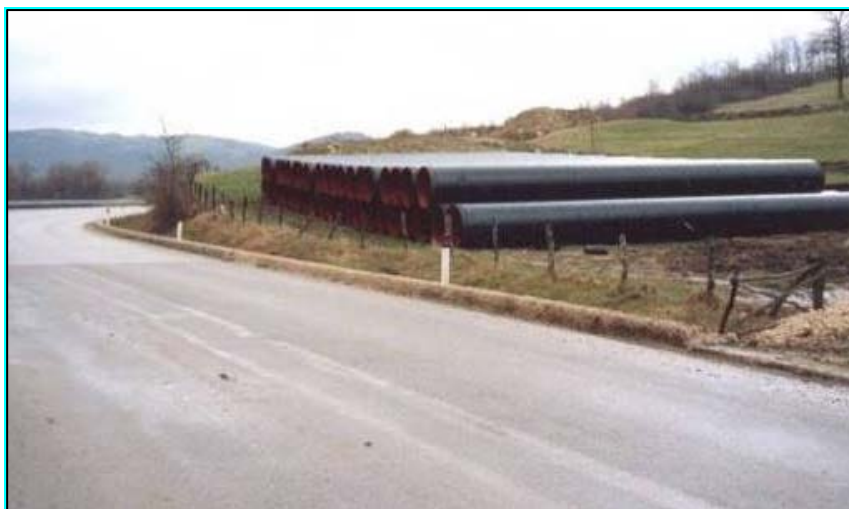
Foto 2.2-1: Piazzola di accatastamento tubazioni
