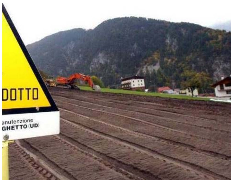
Foto 2.2-6: Ridistribuzione dello strato humico superficiale
