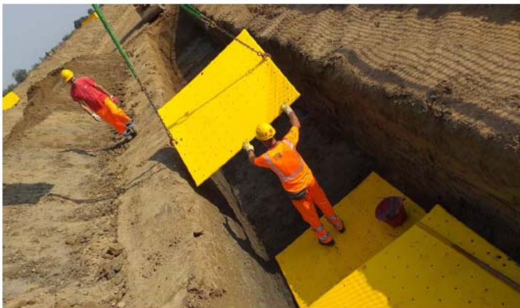
Foto 2.2-5: Rinterro della condotta con piastre HDPE
