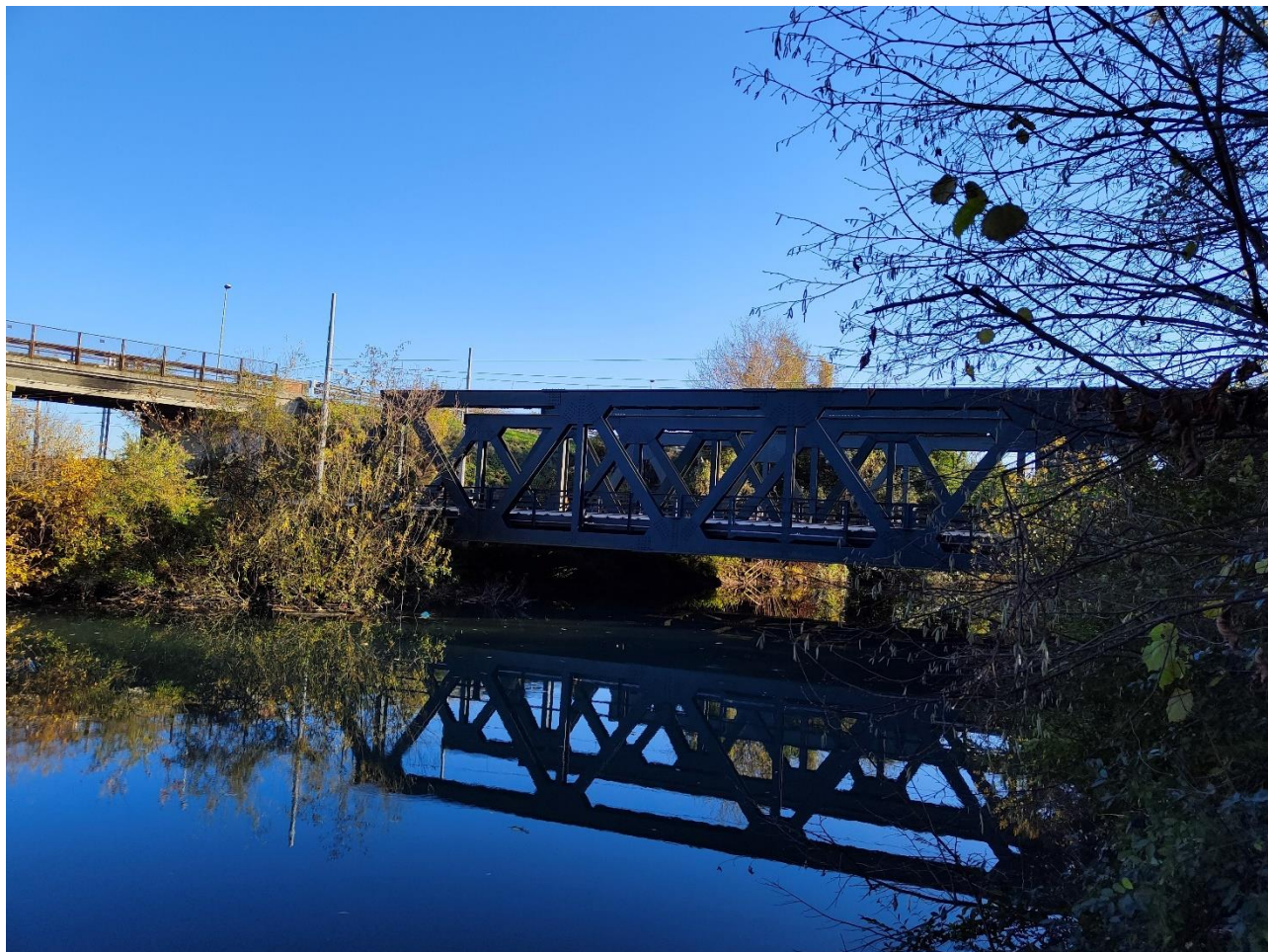
Figura 12 Punto 2: Vegetazione nelle vicinanze dell'attraversamento oggetto dell'intervento
