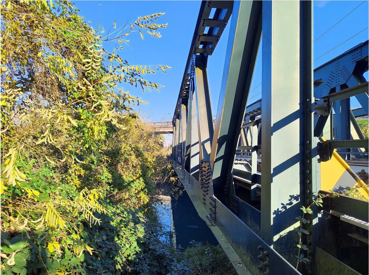
Figura 13 Punto 3: Vegetazione nelle immediate vicinanze della ferrovia
