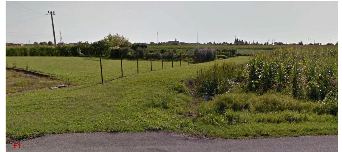
Figura 5-26 Ambito di progetto della SSE Cessalto: visuale da fronte edificato
