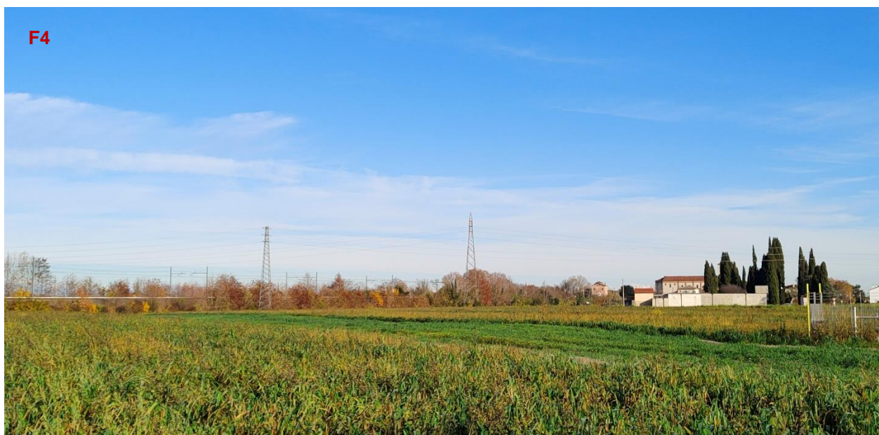
Figura 5-29 Ambito di progetto della SSE Cessalto: visuale da Via Chiesa
