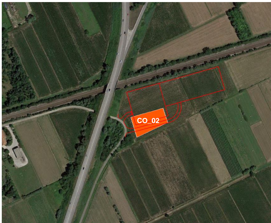
Figura 5-2 Area di cantiere in corrispondenza della SSE Latisana
