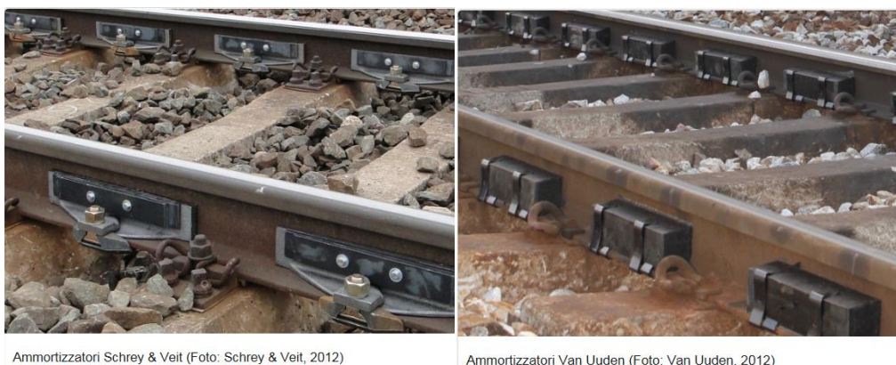
Figura 7-1 Esempio di sistemi di tipo "rail dampers"
