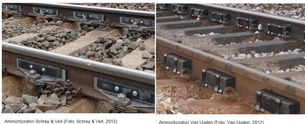
Figura 7-1 Esempio di sistemi di tipo "rail dampers"
