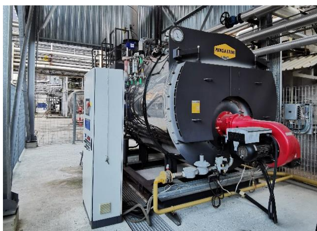
Figura 27 - Caldaie Mingazzini
