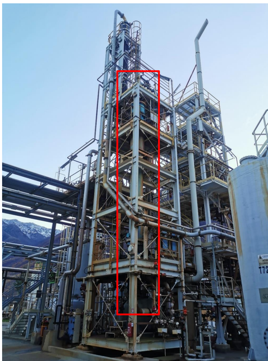
Figura 20 - Impianto HCl di sintesi, nel riquadro rosso è possibile osservare la colonna di reazione
