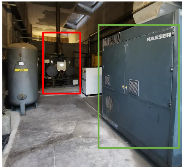
Figura 24 - Locale autoproduzione azoto (riquadro rosso: assorbitore rigenerativo; riquadro verde: compressore aria)
