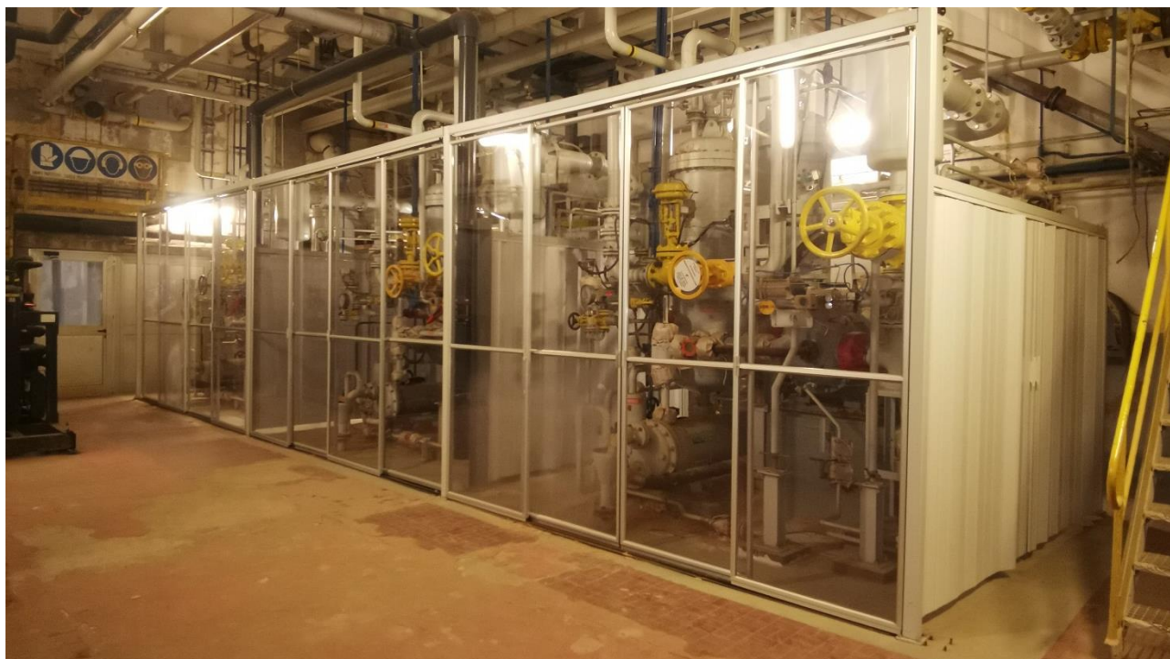
Figura 29 - Gruppi di compressione Cloro
