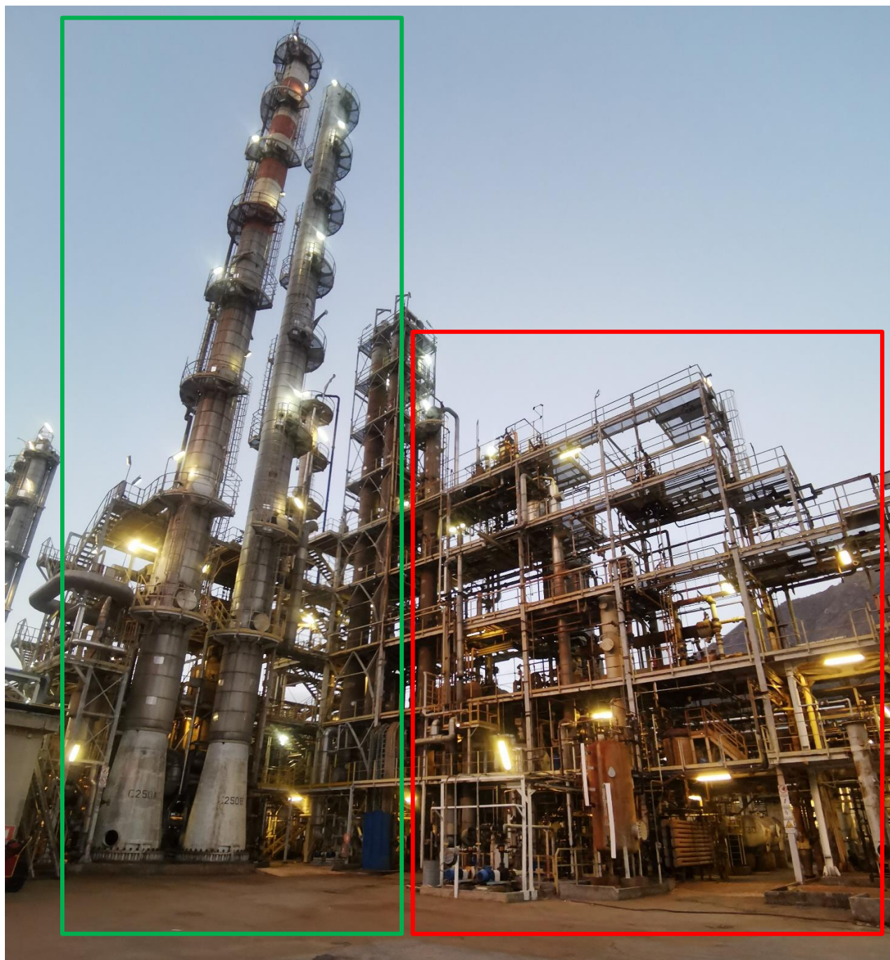
Figura 17 - Immagine fotografica impianto CLAR (semplificando, riquadro rosso è relativo a sezioni di "trattamento" es. fasi di clorurazione ed evaporazione, mentre riquadro verde relativo a sezione produttiva es. fasi di distillazione e cristallizzazione)
