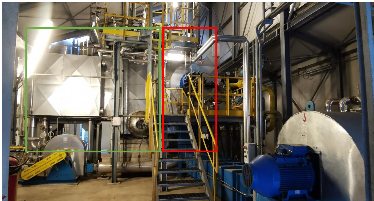
Figura 26 - Caldaia Bono (riquadro verde: economizzatori; riquadro rosso: caldaia con bruciatore bi-fuel, iniettori gas-idrogeno alternati)
