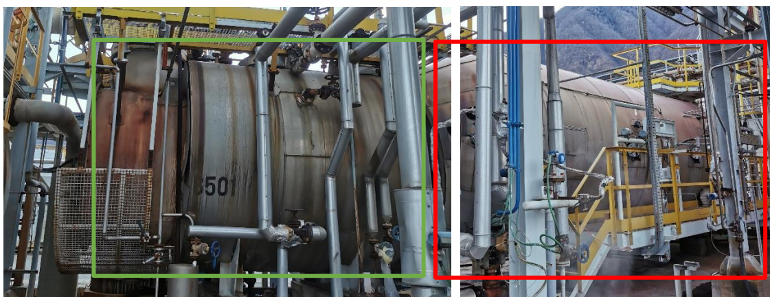
Figura 25 - Termocombustore per il trattamento delle emissioni dell'impianto CLAR (riquadro rosso: termocombustore, riquadro verde: recuperatore di calore per la produzione di vapore)
