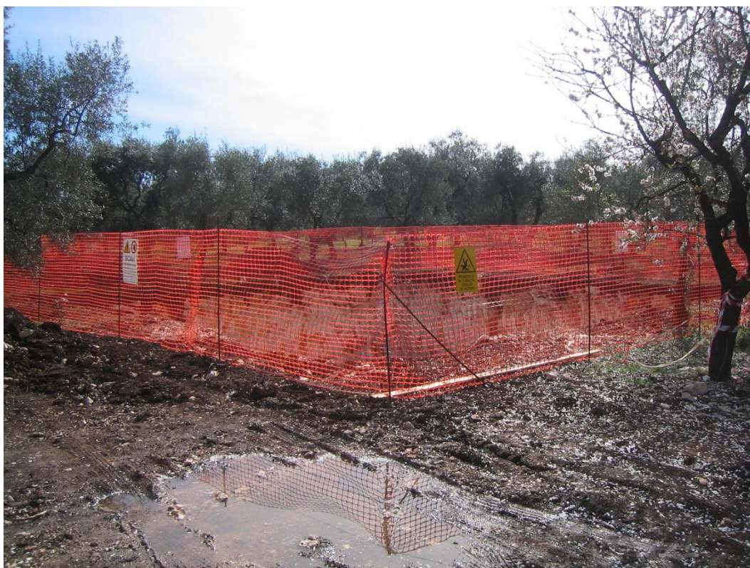
Figura 2: Area di cantiere per la piazzola sostegno
