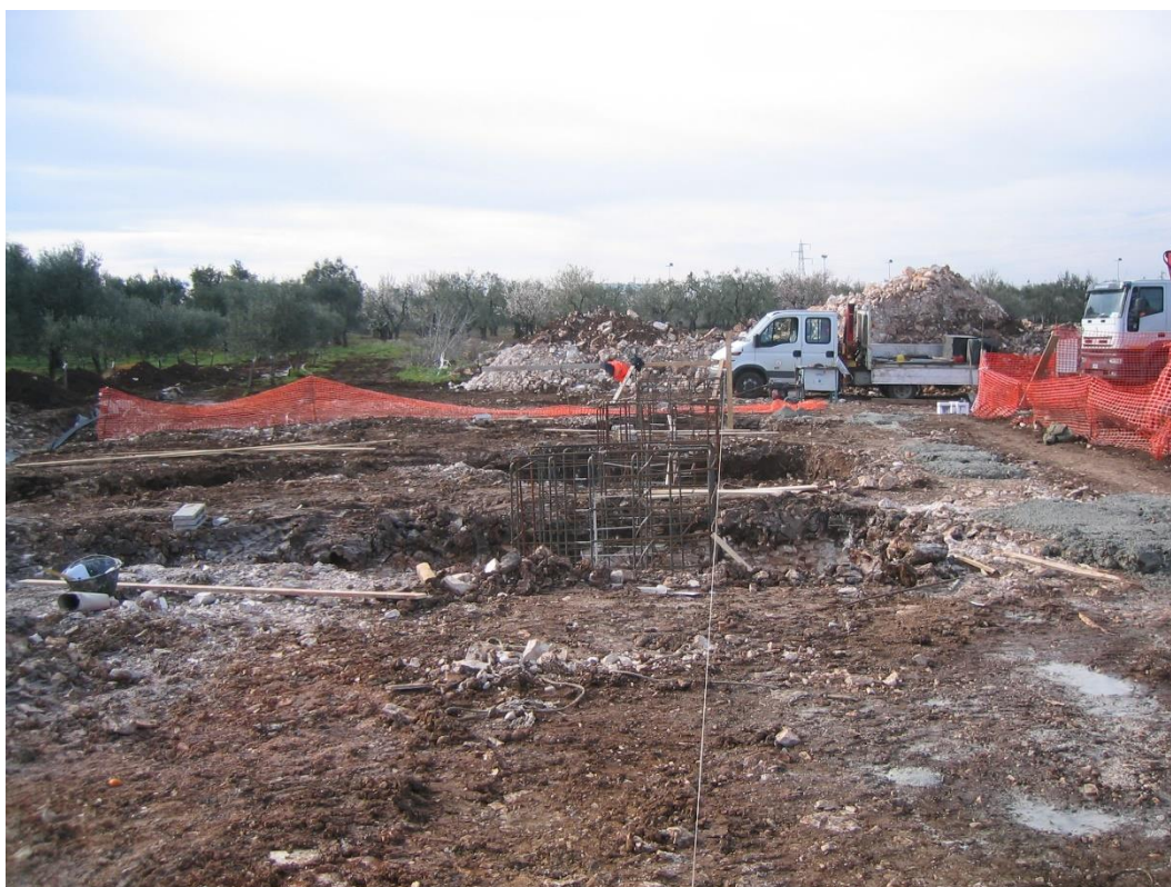
Figura 3: Buche per l'alloggiamento delle fondazioni
