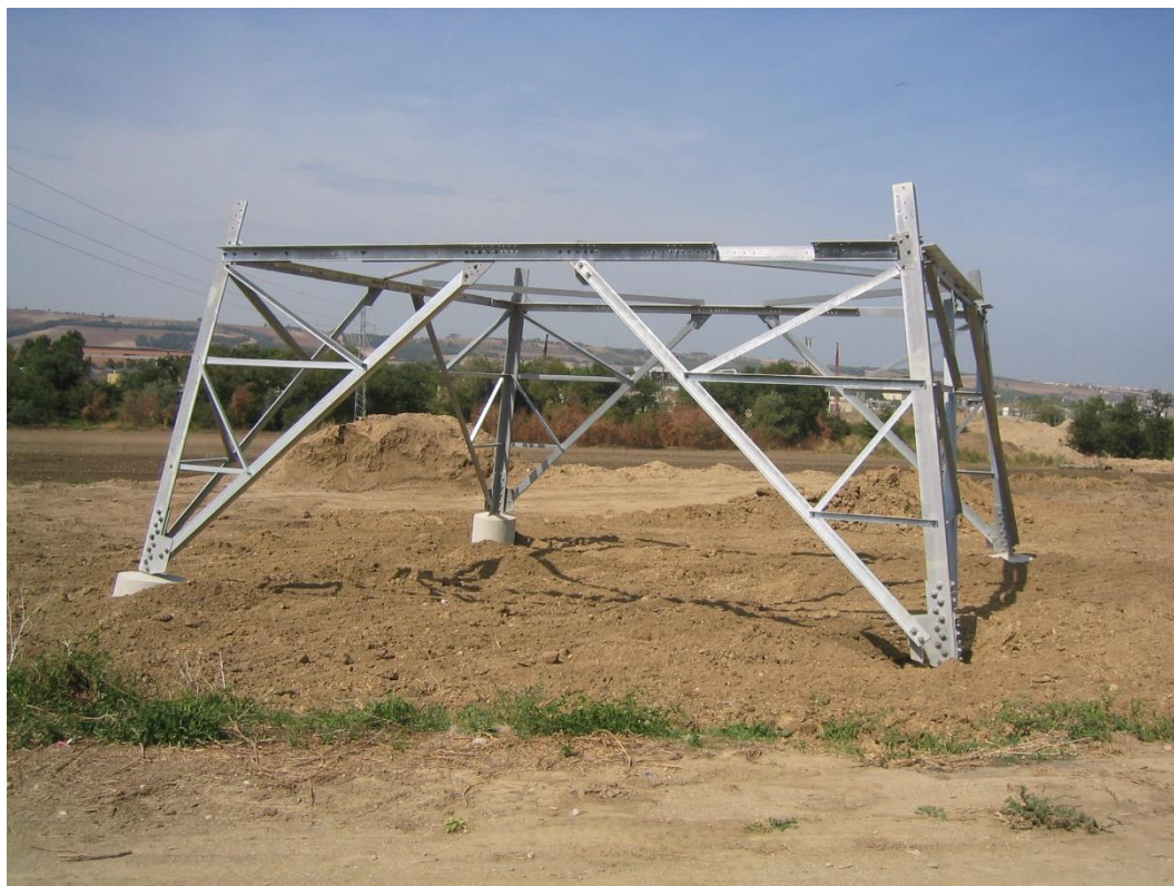
Figura 4: Base del sostegno dopo ricopertura degli scavi
