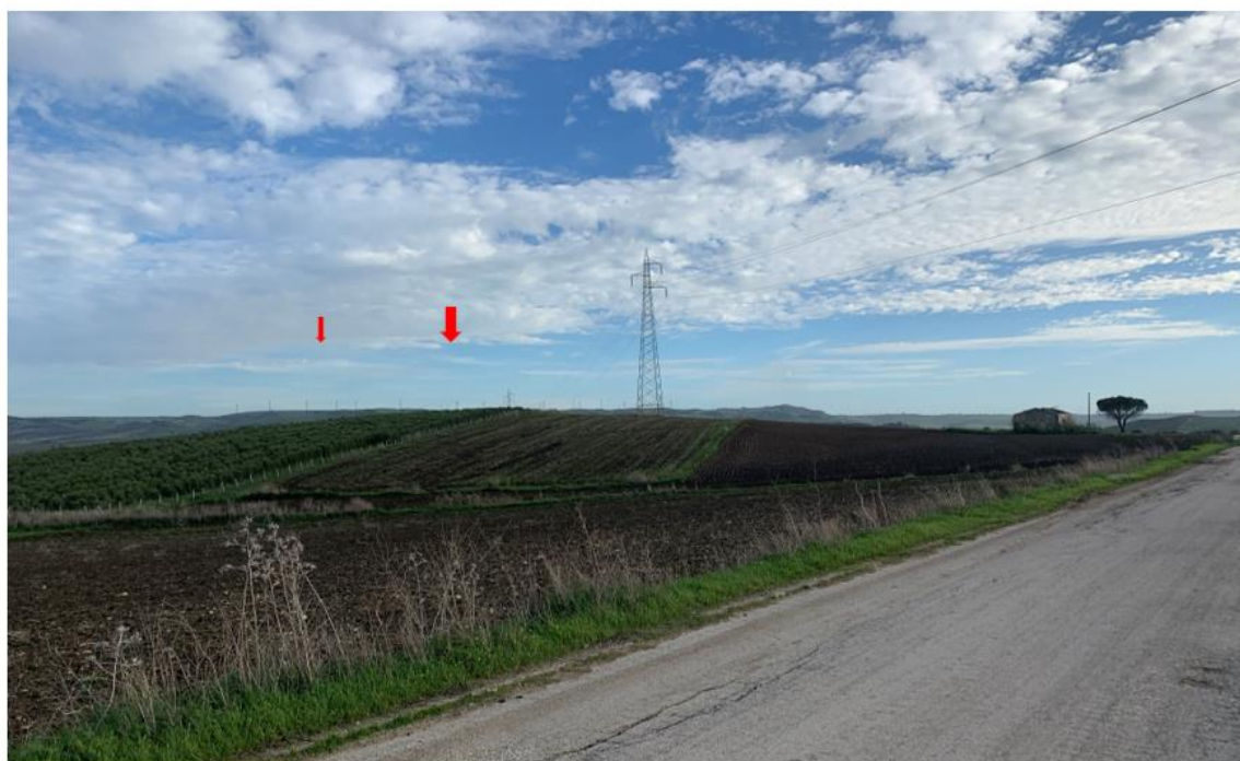
Figura 66. Posizionamento tralicci 29N-30N (fotografia scattata dalla Strada Provinciale SP50 in data 28.11.22).
