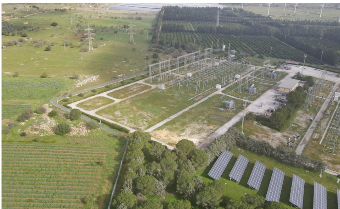
Figura 70. Posizionamento Stazione "Partanna" (fotografia aerea scattata in data 28.11.22)
