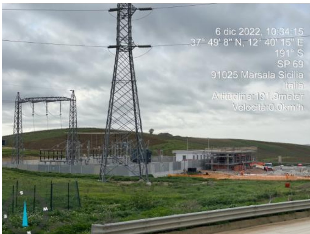
Lavori in corso ampliamento stazione "Partanna 2"
