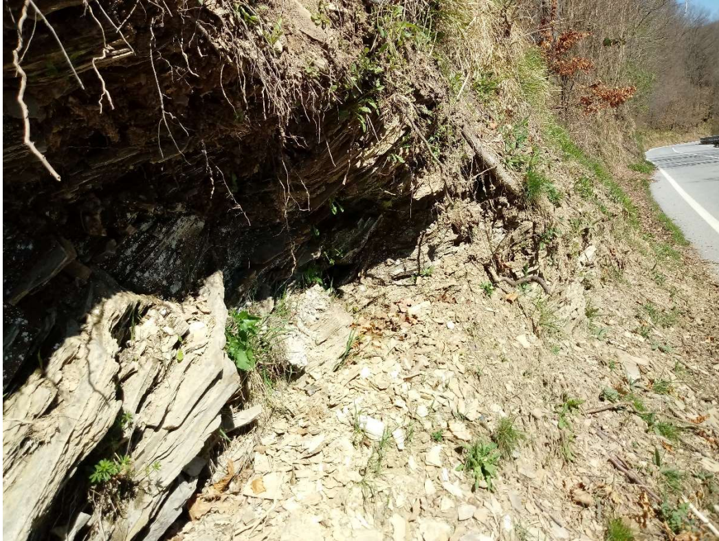
Figura 19. Coltri eluvio-colluviali (nel caso rappresentato prevalentemente eluviali) di colore giallo ocra accumulate alla base di un affioramento di substrato litoide costituito dalle torbiditi della Formazione di Ronco (ROC). I depositi in esame sono costituiti prevalentemente da clasti appiattiti di areniti, siltiti e peliti.
