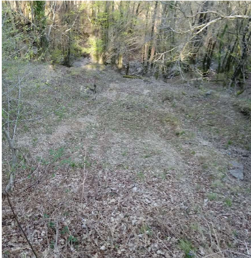
Figura 20. Depositi antropici prodotti probabilmente da scavi di sbancamento per la realizzazione della S.S.45 ed accumulati a valle dell'infrastruttura (vicinanze del punto di rilievo n°16). Si notino i solchi lineari e gli avvallamenti prodotti dall'erosione operata dalle acque ruscellanti.
