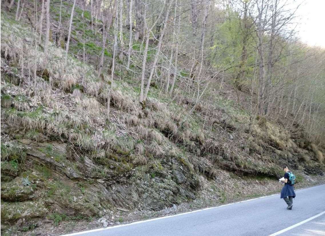
Figura 35. Vista delle superfici di stratificazione disposte a franapoggio meno inclinato del pendio presso il quale si sono sviluppate delle frane da scivolamento planare lungo le superfici di strato (Punto di rilievo n°17).
