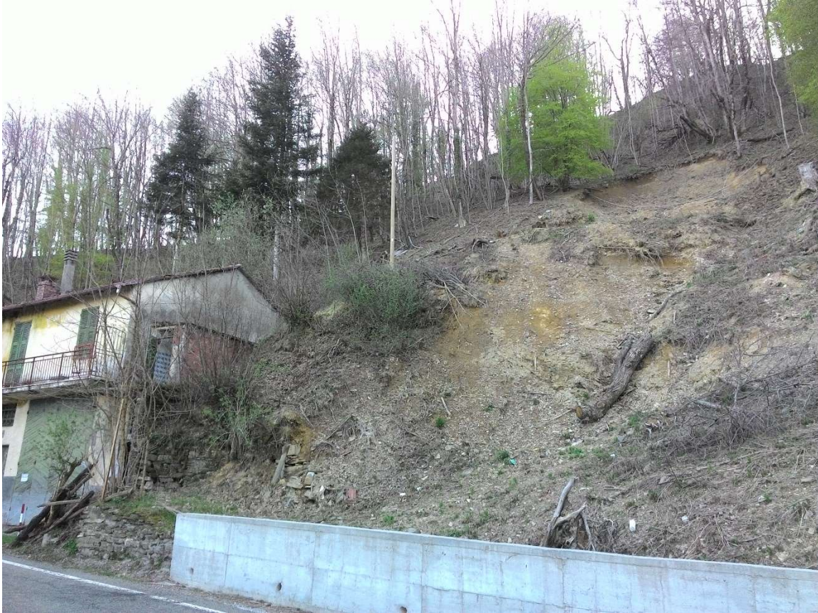
Figura 36. Nicchia di distacco di una frana di scivolamento/colamento superficiale osservata a ridosso della strada S.S. 45. Punto di rilievo n°37.
