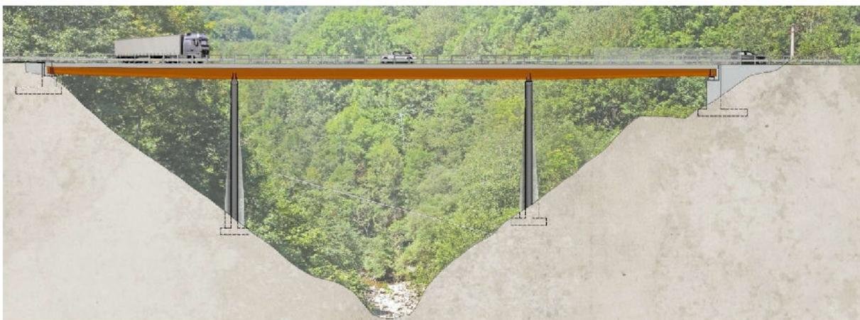
L'enfasi della differenziazione fra le due componenti strutturali è evidenziata anche dal trattamento delle spalle che definiscono le testate, dove, analogamente alle pile, si è mantenuta la semplice finitura del calcestruzzo.
