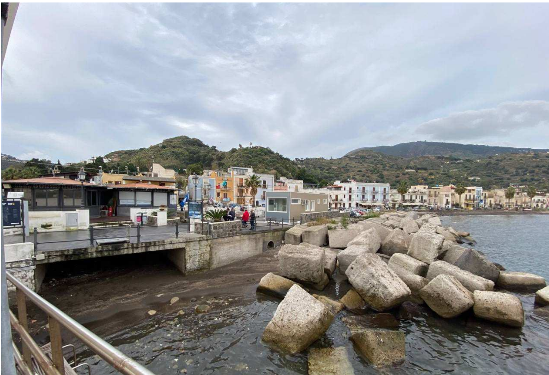
Figura 7. Lipari. Marina Lunga. Area di interesse progettuale. Vista da est.
