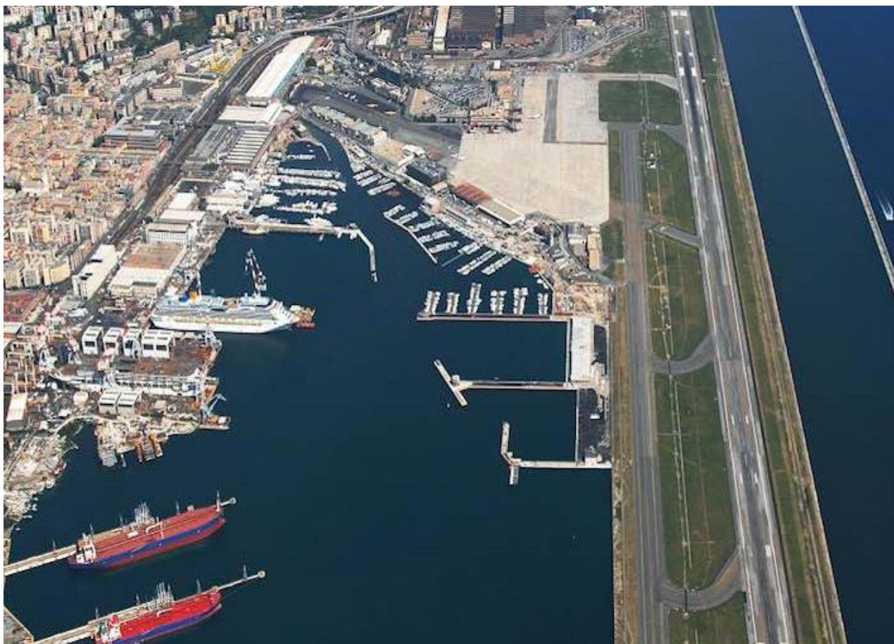
Figura 1 – Vista area delle aree d'intervento
