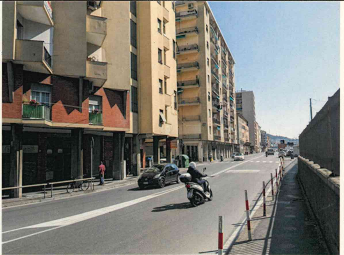
Fig 1: vista della SS1 dall'ingresso di Fincantieri
