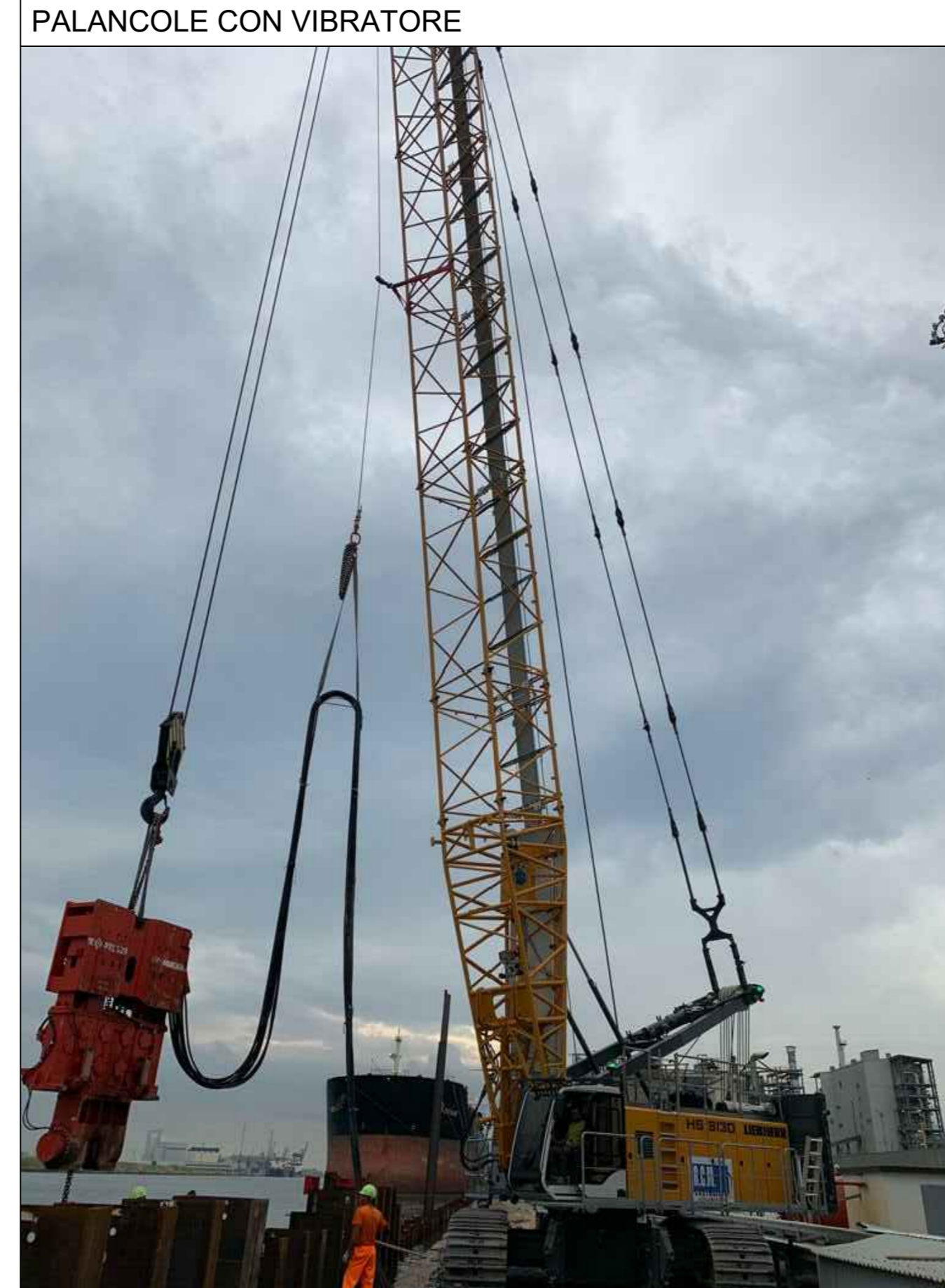
GRU CINGOLATA LIEBHERR "HS 8130 HD": INFISSIONE PALANCOLE CON VIBRATORE
