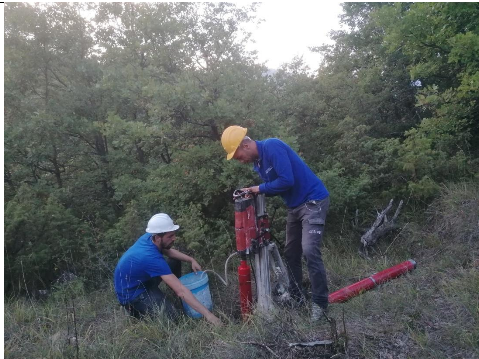
Esecuzione carotaggio P. 100
