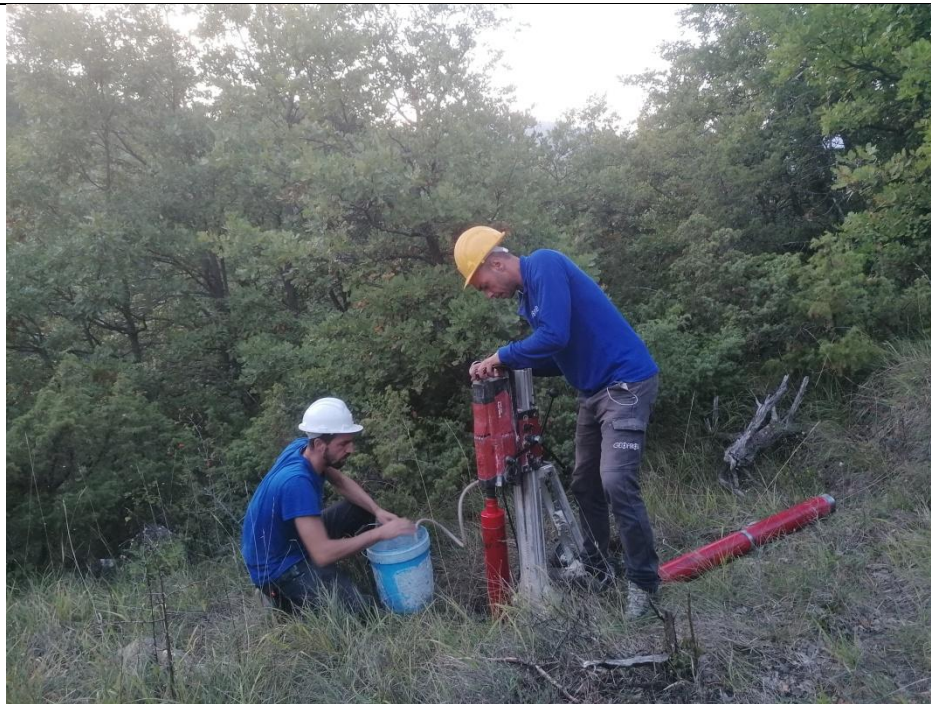
Esecuzione carotaggio P. 100
