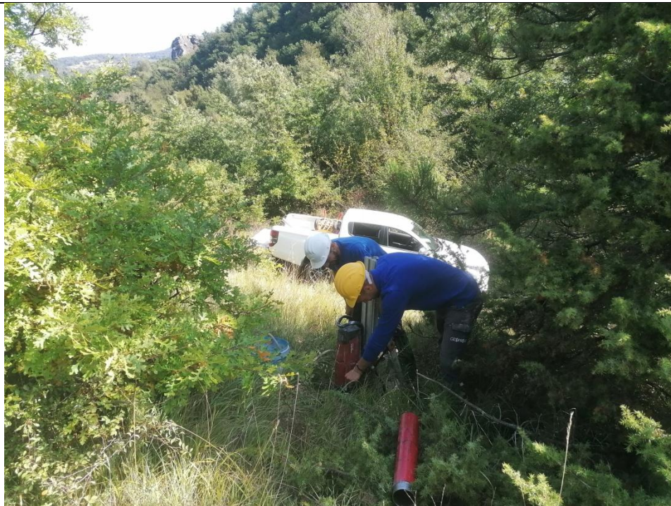
Esecuzione carotaggio P. 101
