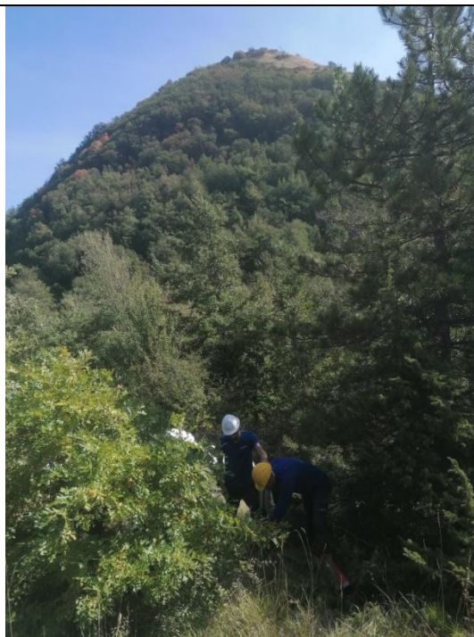
Esecuzione carotaggio P. 101
