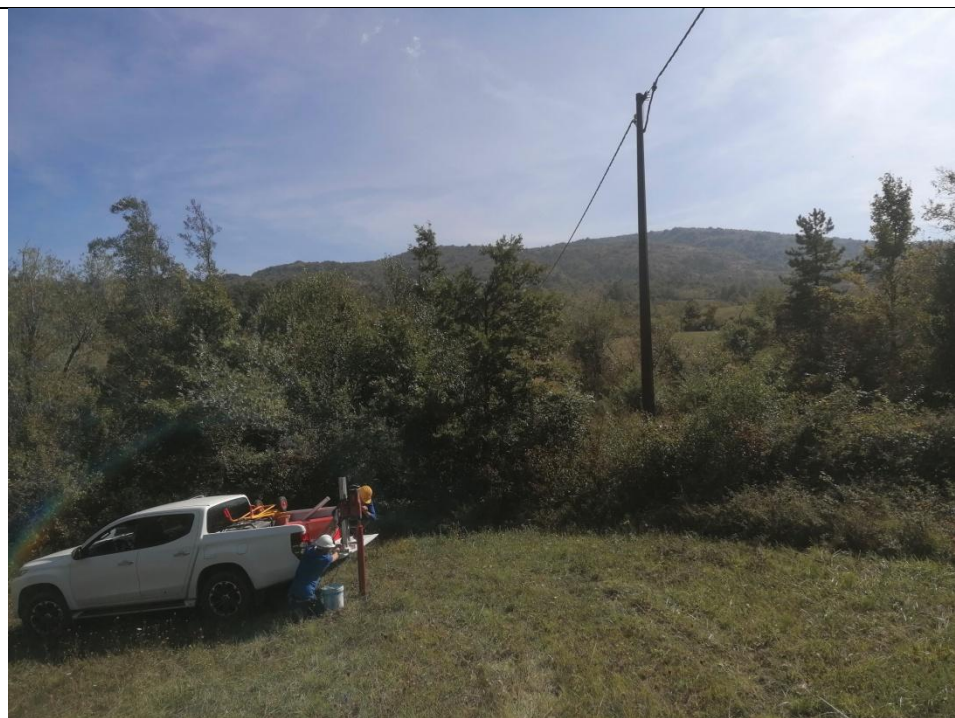
Esecuzione carotaggio P. 102
