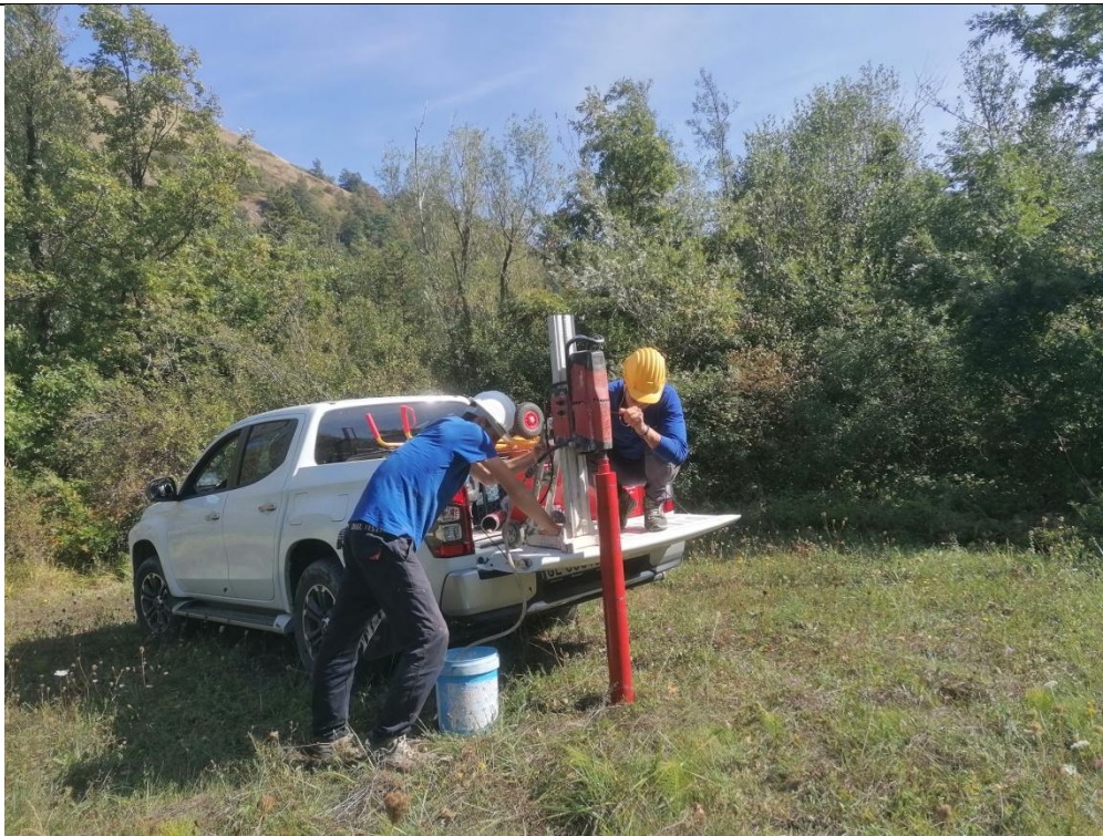
Esecuzione carotaggio P. 102
