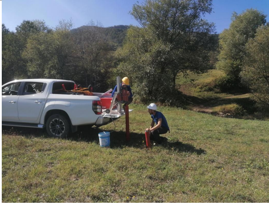
Esecuzione carotaggio P. 104
