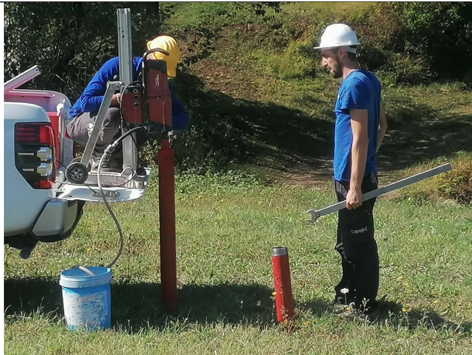
Esecuzione carotaggio P. 104
