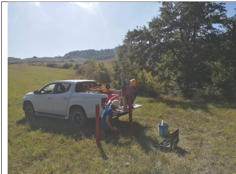
Esecuzione carotaggio P. 105
