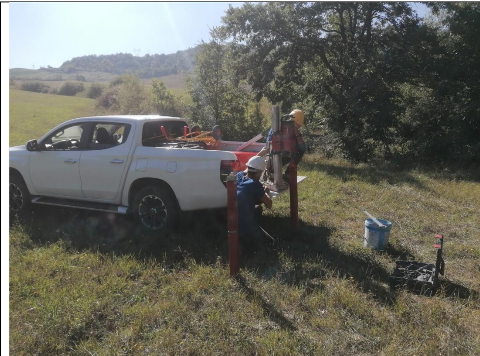
Esecuzione carotaggio P. 105
