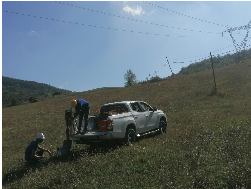
Esecuzione carotaggio P. 106
