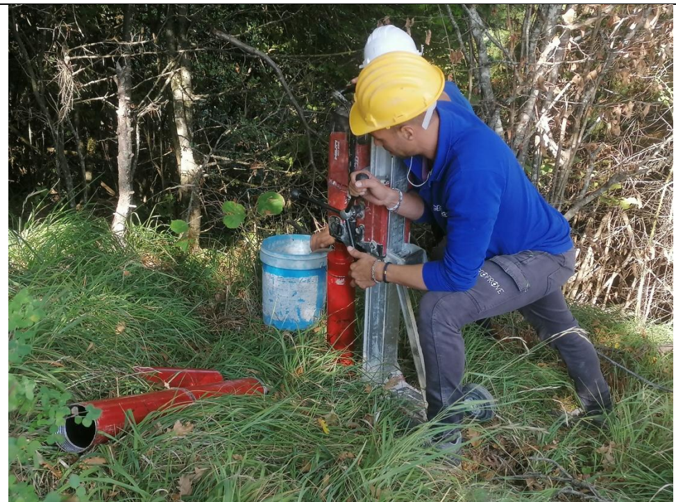
Esecuzione carotaggio P. 107
