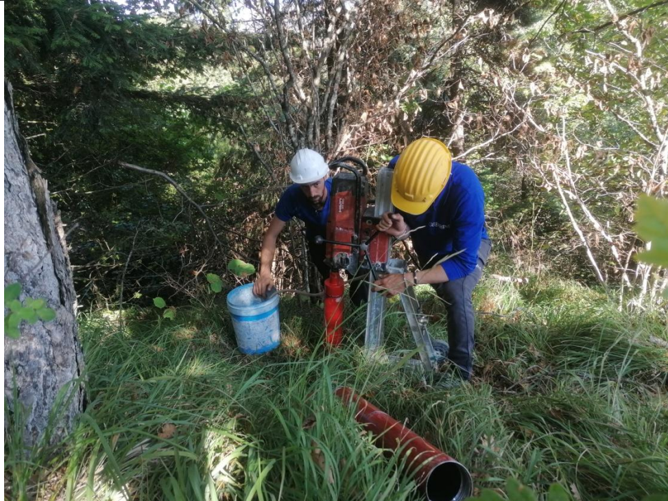
Esecuzione carotaggio P. 107
