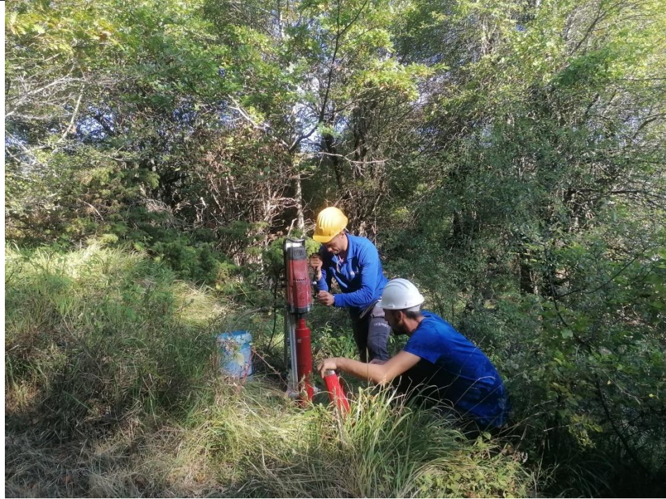
Esecuzione carotaggio P. 109
