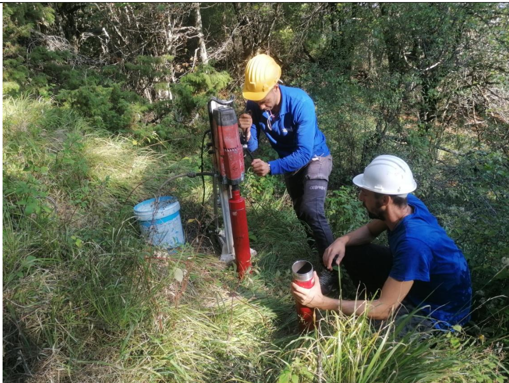
Esecuzione carotaggio P. 109
