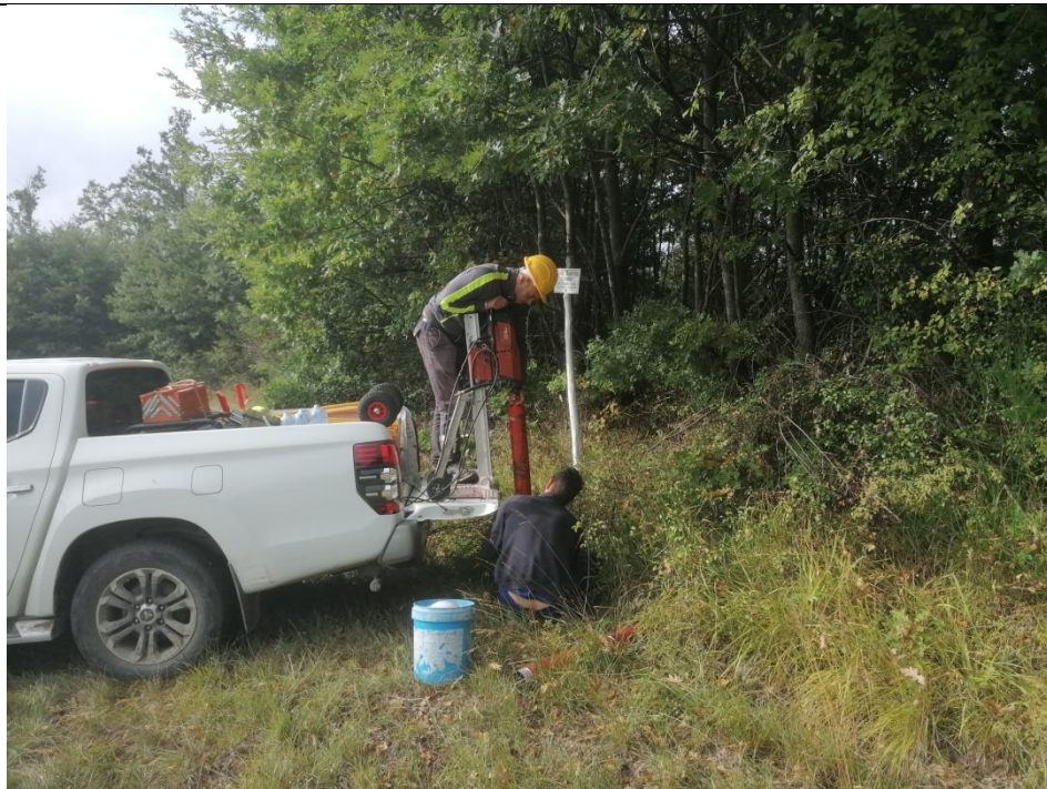
Esecuzione carotaggio P. 10H
