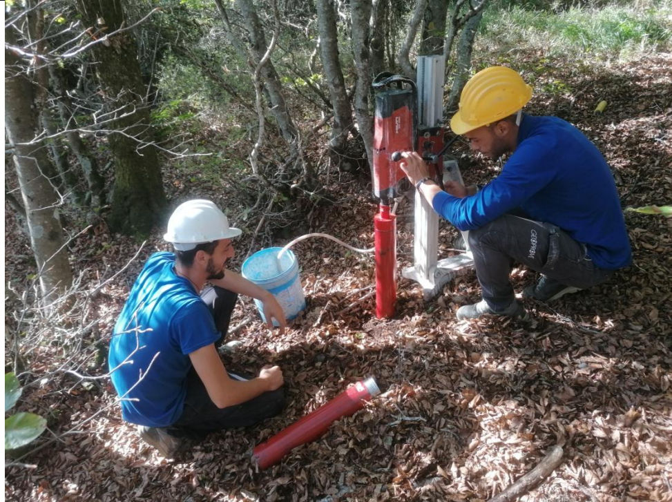
Esecuzione carotaggio P. 116
