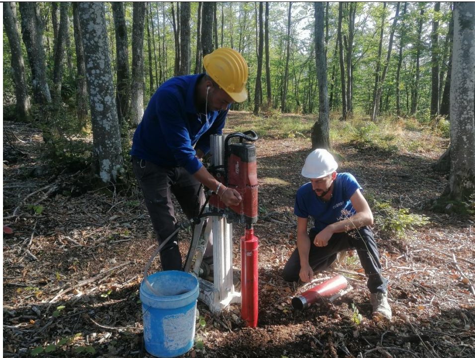
Esecuzione carotaggio P. 117
