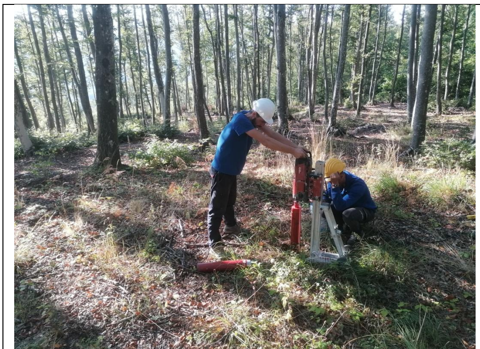
Esecuzione carotaggio P. 118
