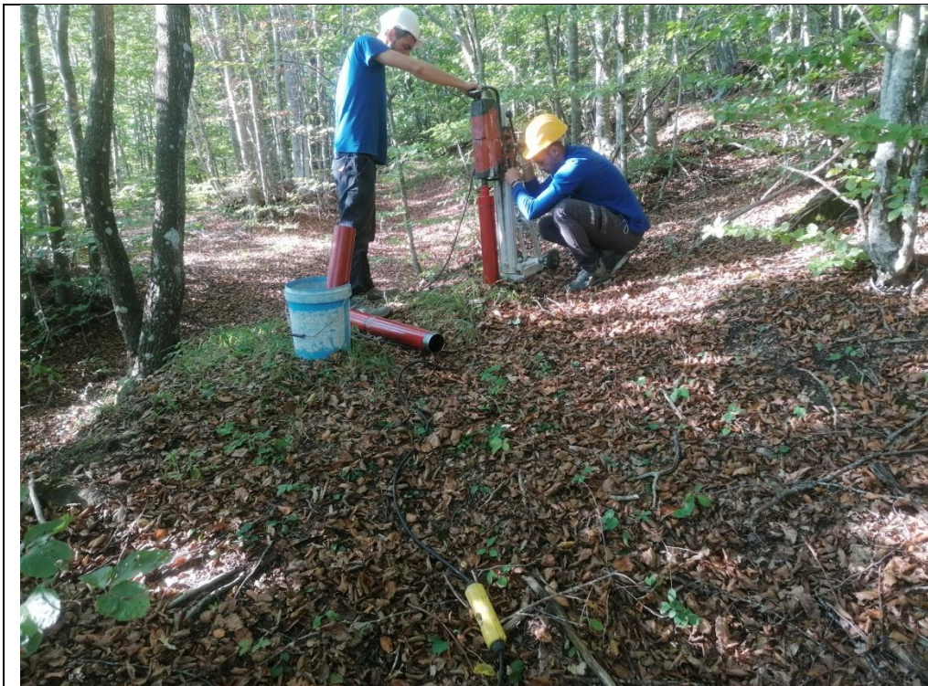
Esecuzione carotaggio P. 119
