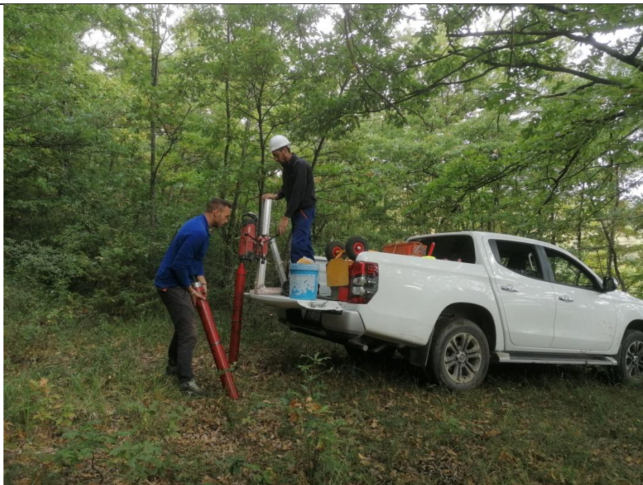
Esecuzione carotaggio P. 11H
