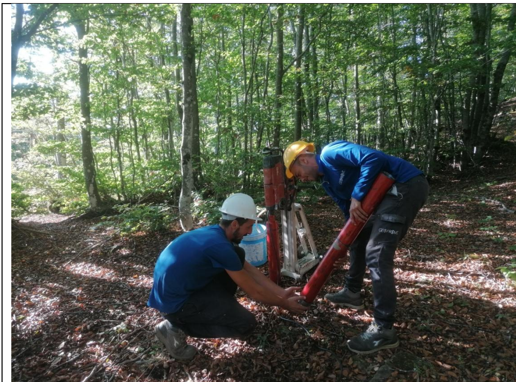
Esecuzione carotaggio P. 120
