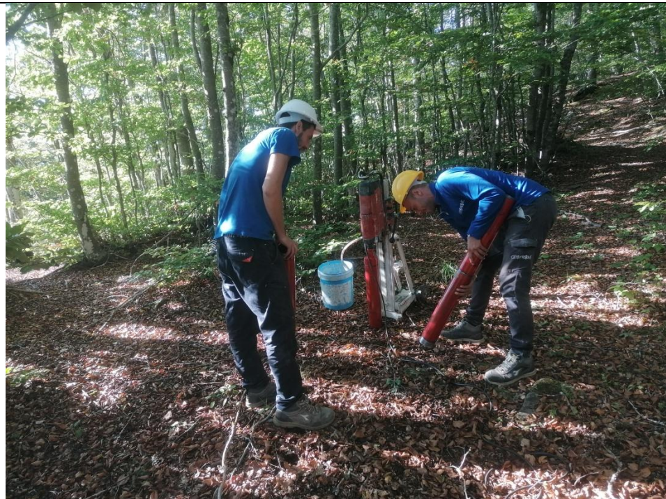
Esecuzione carotaggio P. 120
