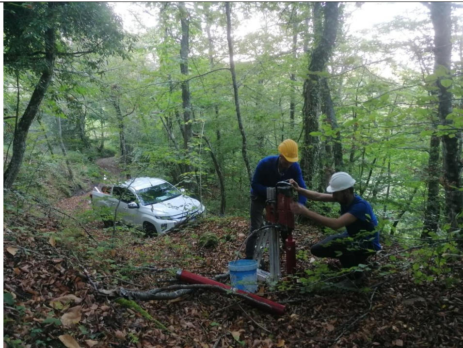
Esecuzione carotaggio P. 121
