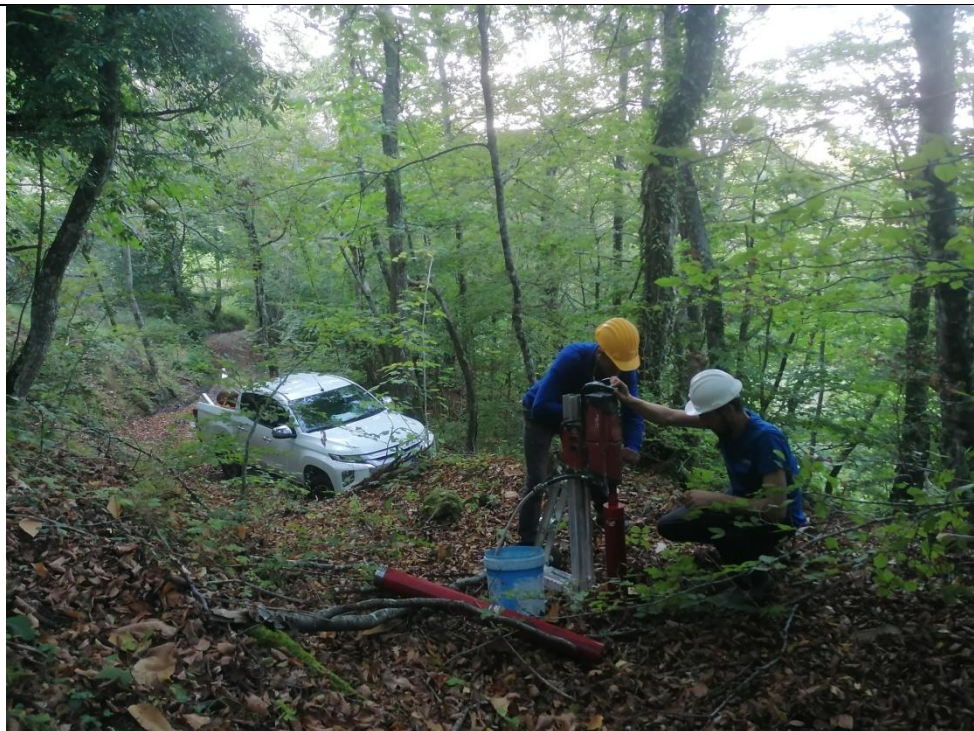
Esecuzione carotaggio P. 121
