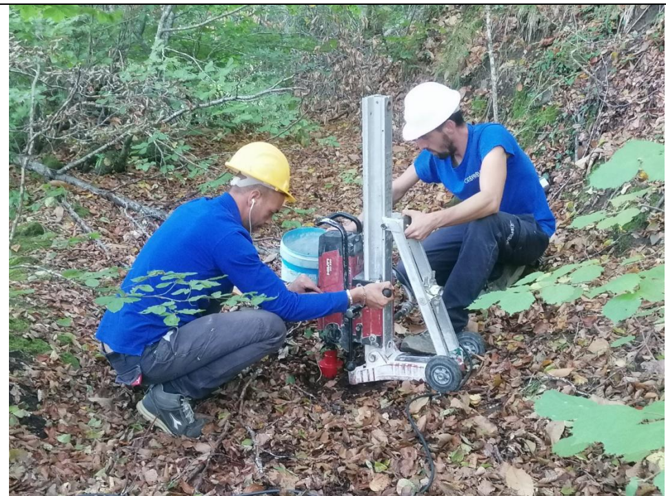
Esecuzione carotaggio P. 122
