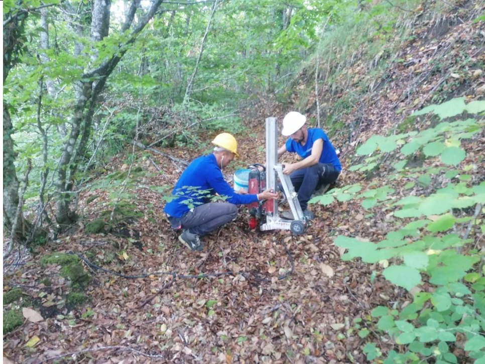
Esecuzione carotaggio P. 122
