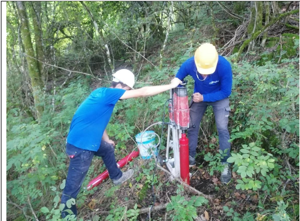
Esecuzione carotaggio P. 123
