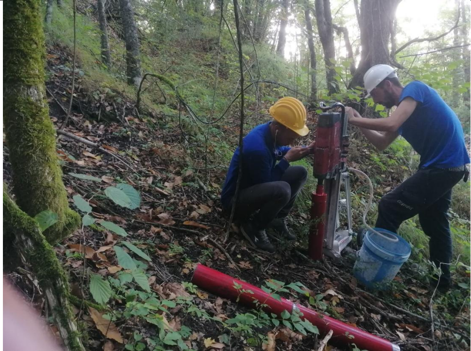
Esecuzione carotaggio P. 124
