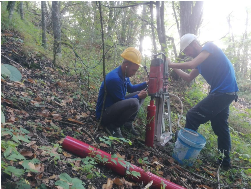
Esecuzione carotaggio P. 124
