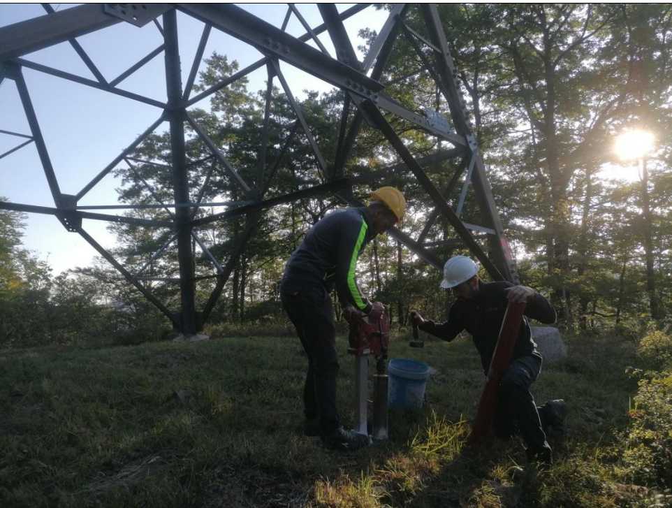
Esecuzione carotaggio P. 125
