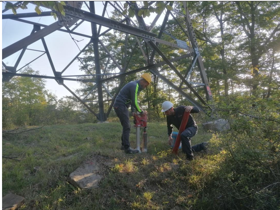
Esecuzione carotaggio P. 125
