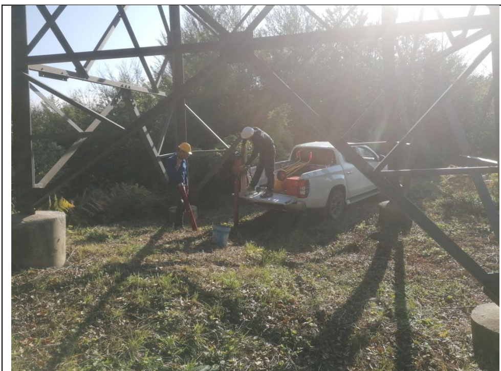
Esecuzione carotaggio P. 127
