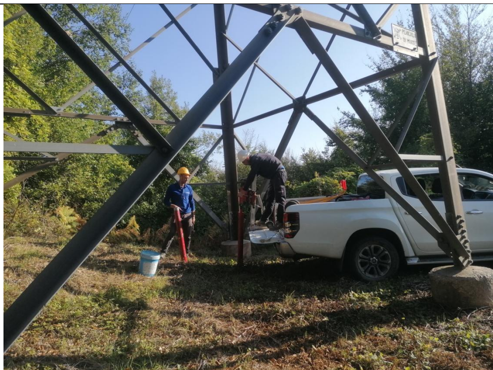
Esecuzione carotaggio P. 127
