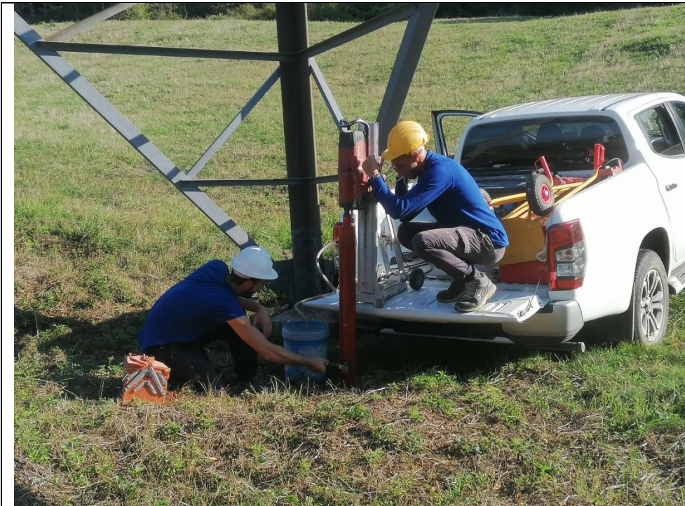
Esecuzione carotaggio P. 128
