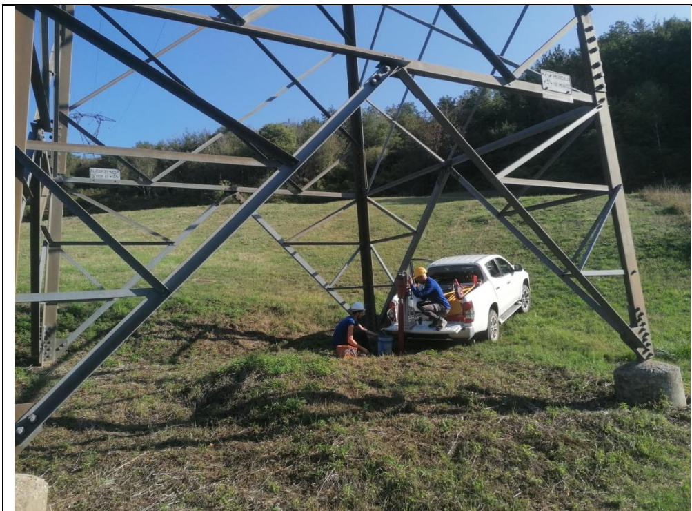
Esecuzione carotaggio P. 128
