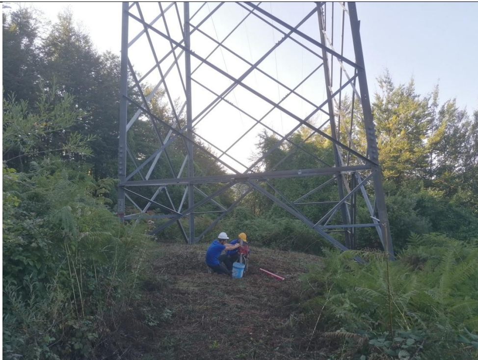
Esecuzione carotaggio P. 129
