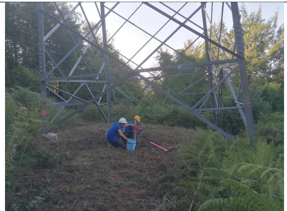
Esecuzione carotaggio P. 129
