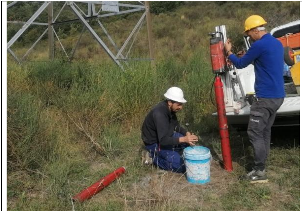
Esecuzione carotaggio P. 12H
