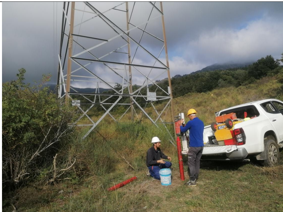
Esecuzione carotaggio P. 12Hincl
