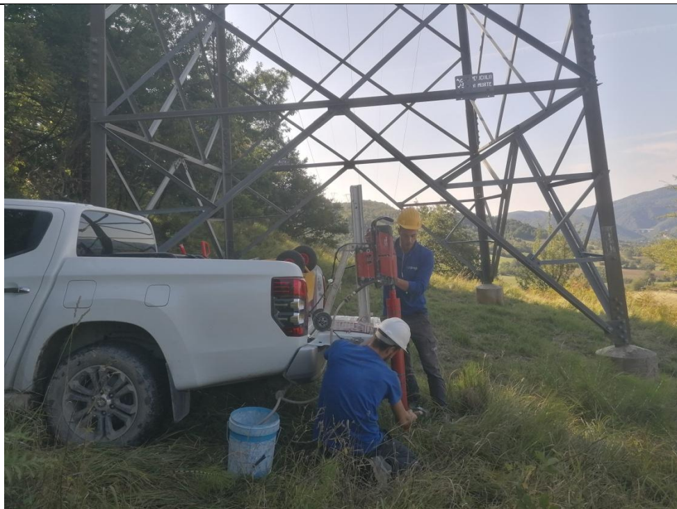
Esecuzione carotaggio P. 130
