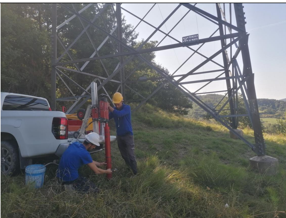
Esecuzione carotaggio P. 130
