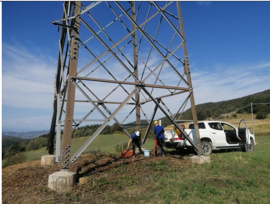
Esecuzione carotaggio P. 131
