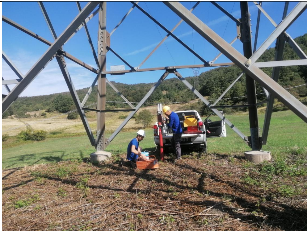
Esecuzione carotaggio P. 131
