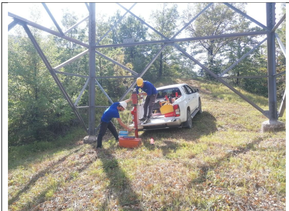
Esecuzione carotaggio P. 133
