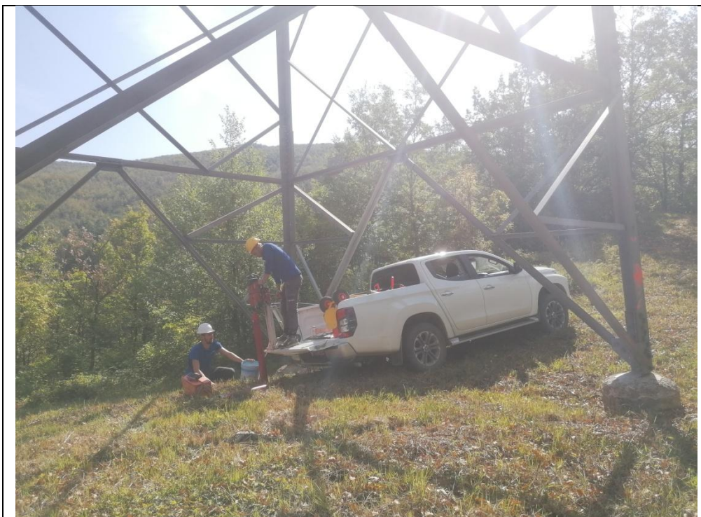
Esecuzione carotaggio P. 133
