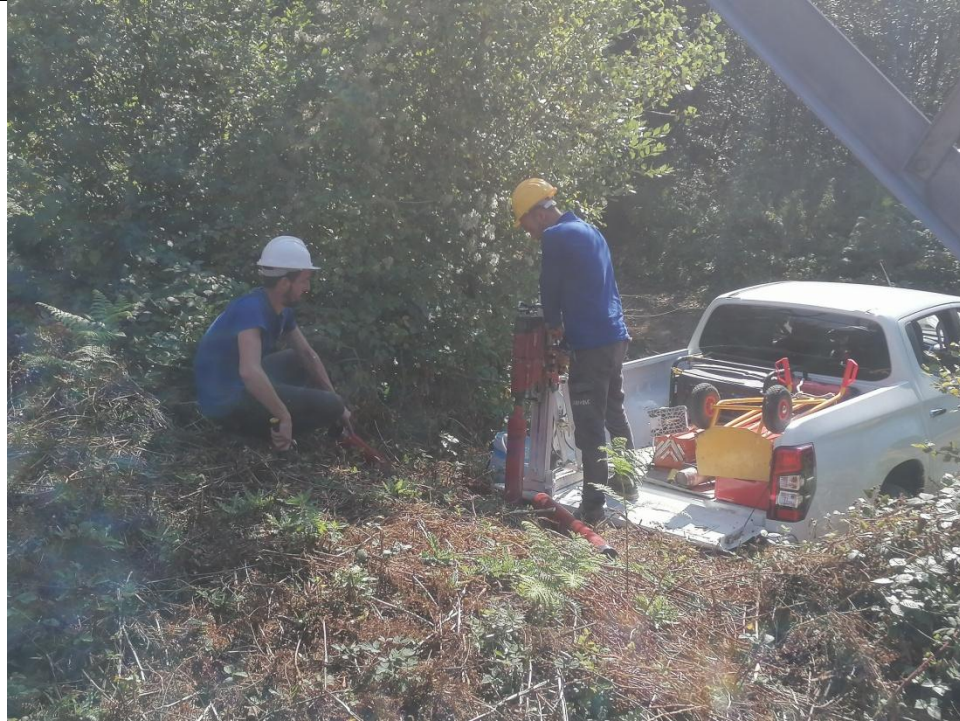
Esecuzione carotaggio P. 134
