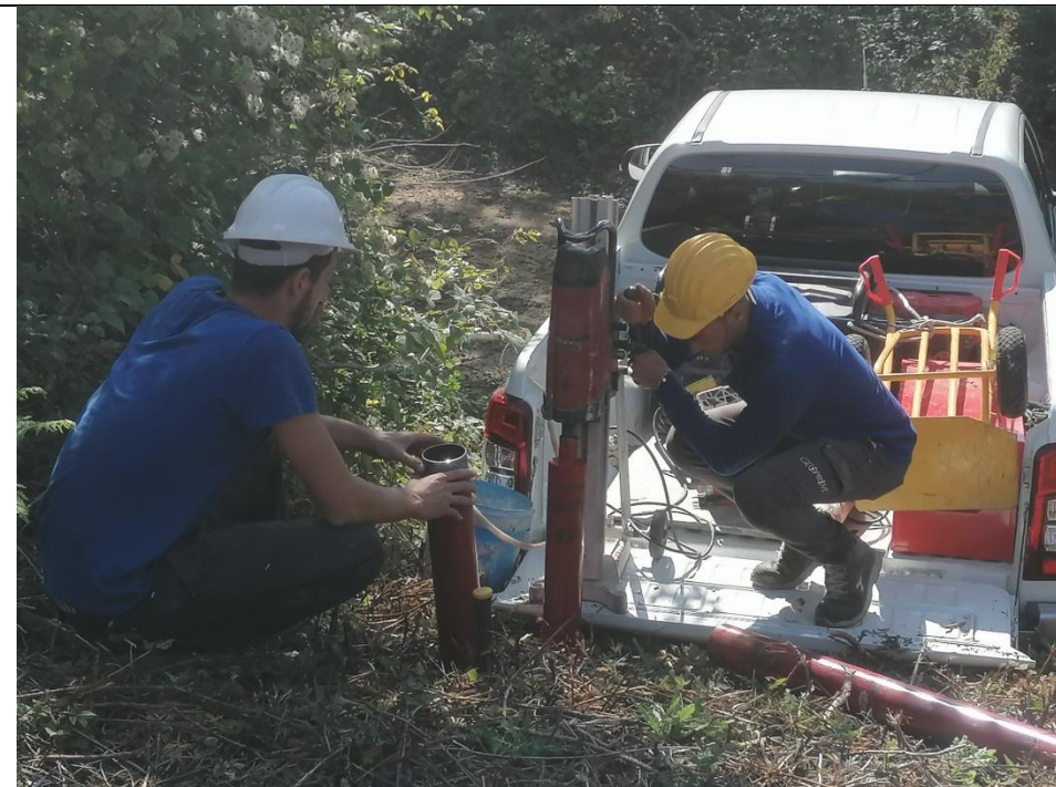
Esecuzione carotaggio P. 134
