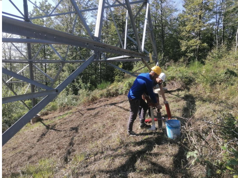
Esecuzione carotaggio P. 135
