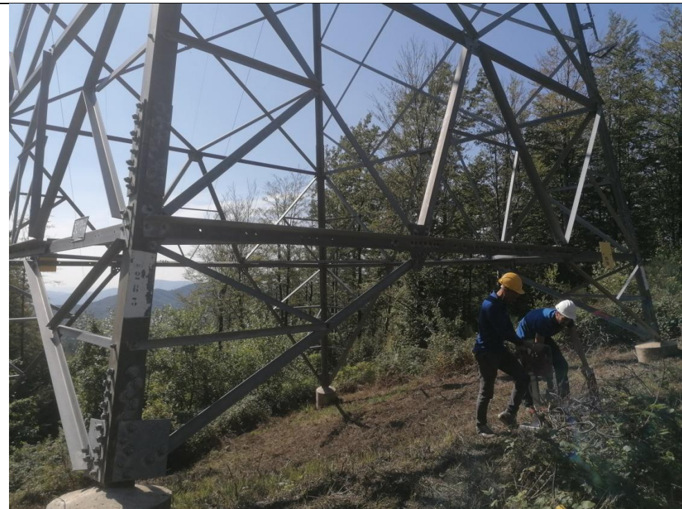
Esecuzione carotaggio P. 135
