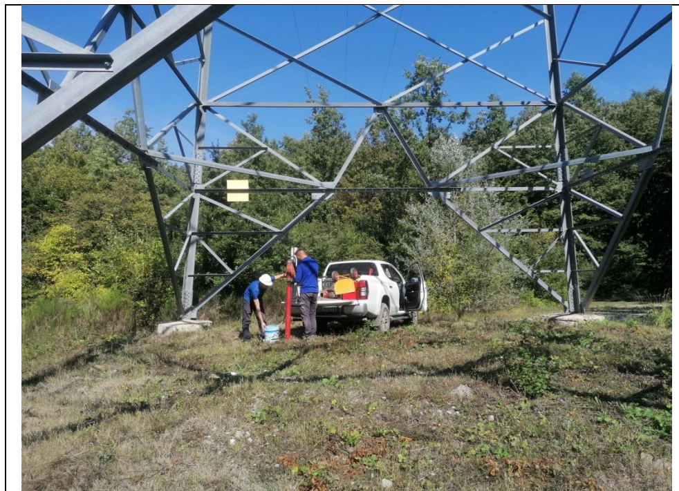
Esecuzione carotaggio P. 136
