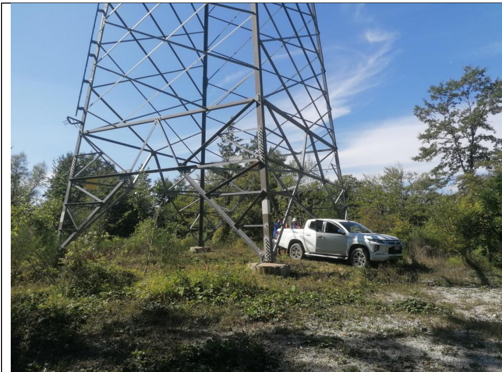
Esecuzione carotaggio P. 136
