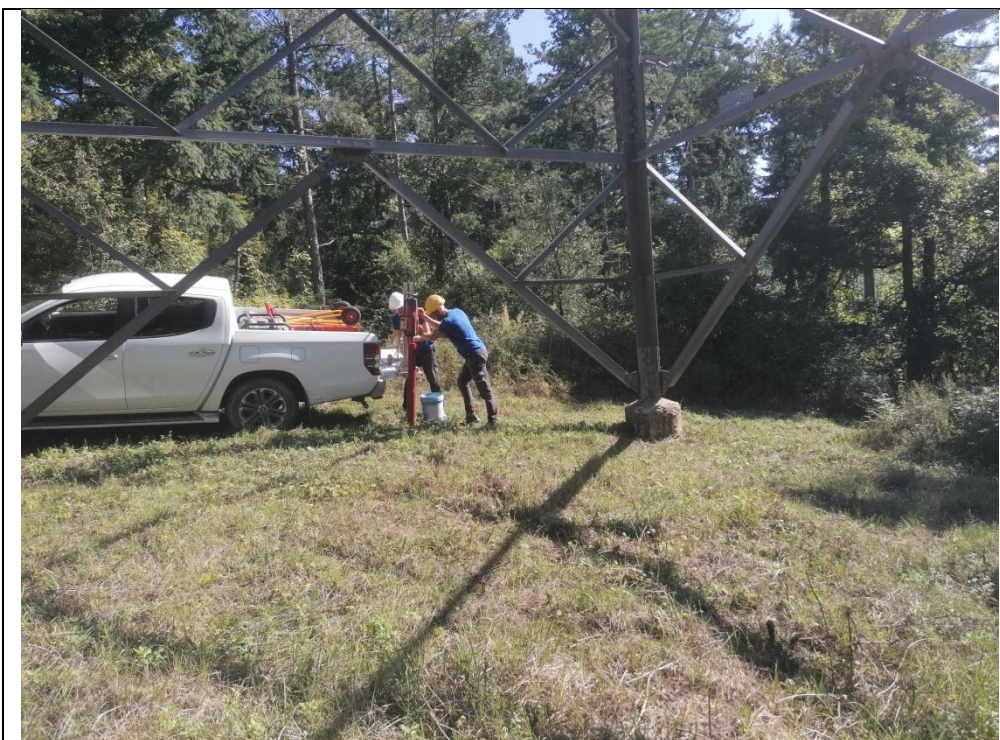
Esecuzione carotaggio P. 137
