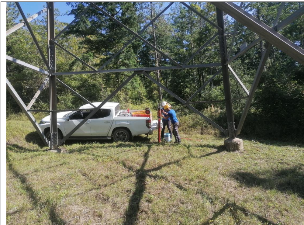
Esecuzione carotaggio P. 137
