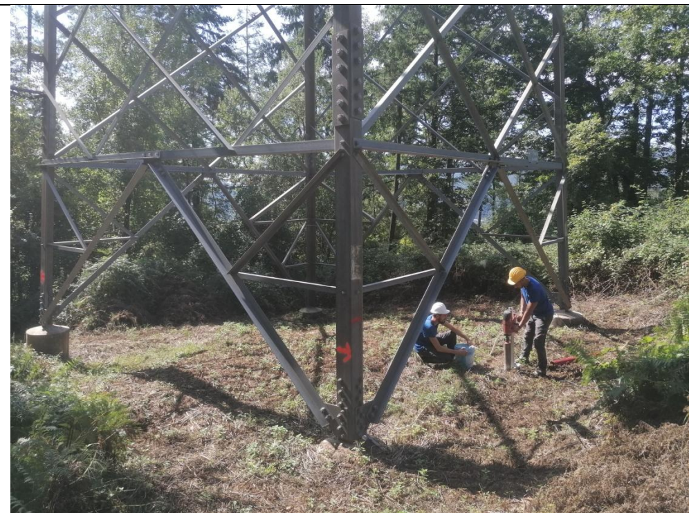
Esecuzione carotaggio P. 138
