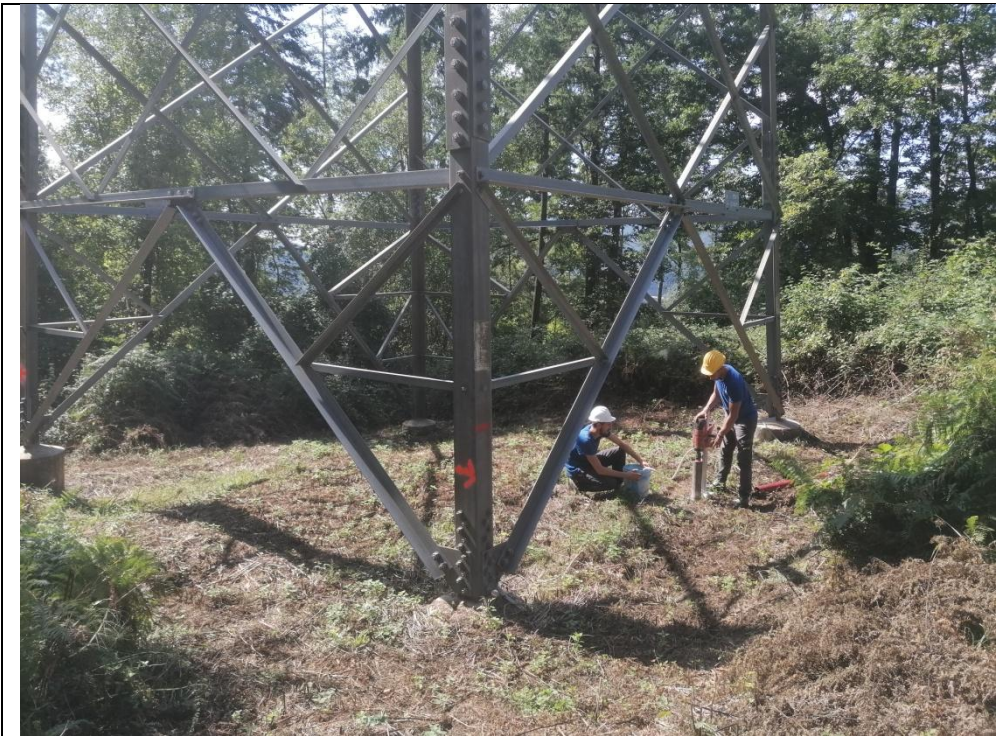
Esecuzione carotaggio P. 138
